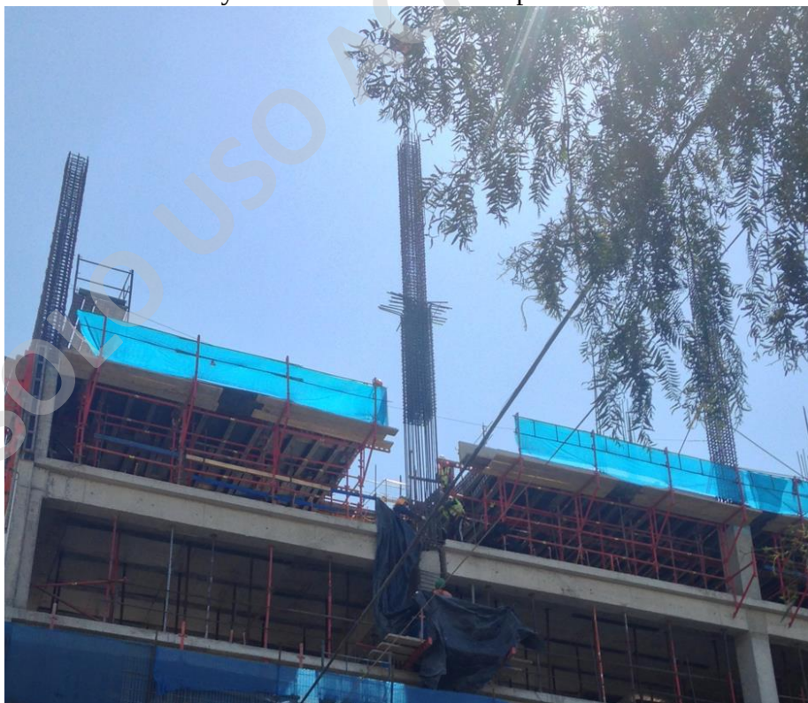
Imagen N° 24: Descenso del pilar pre armado en eje B, visto desde la calzada – Proyecto Centro Médico Independencia.
