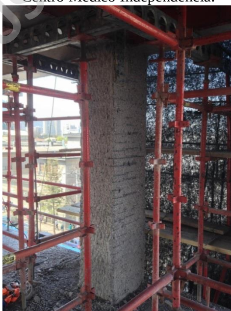
Imagen N° 12: Superficie de pilar con 100% de rugosidad, ejes B/2, 4° piso – Proyecto Centro Médico Independencia.
