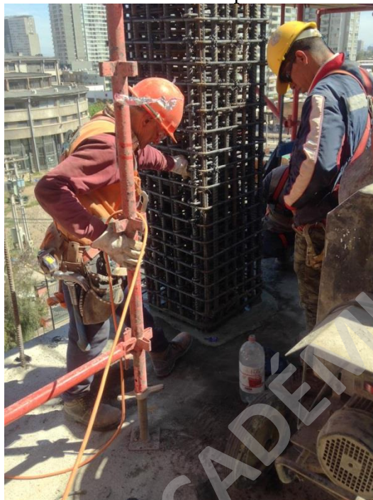
Imagen N° 30: Pilar llenado hasta el nivel de losa del 5° piso, ejes B/2 – Proyecto Centro Médico Independencia.
