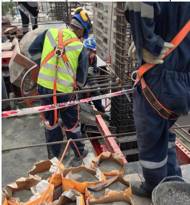
Imagen N° 36: Vertido de la mezcla desde la plataforma habilitada en 5° piso a nivel de cielo, ejes A/2 – Proyecto Centro Médico Independencia.
