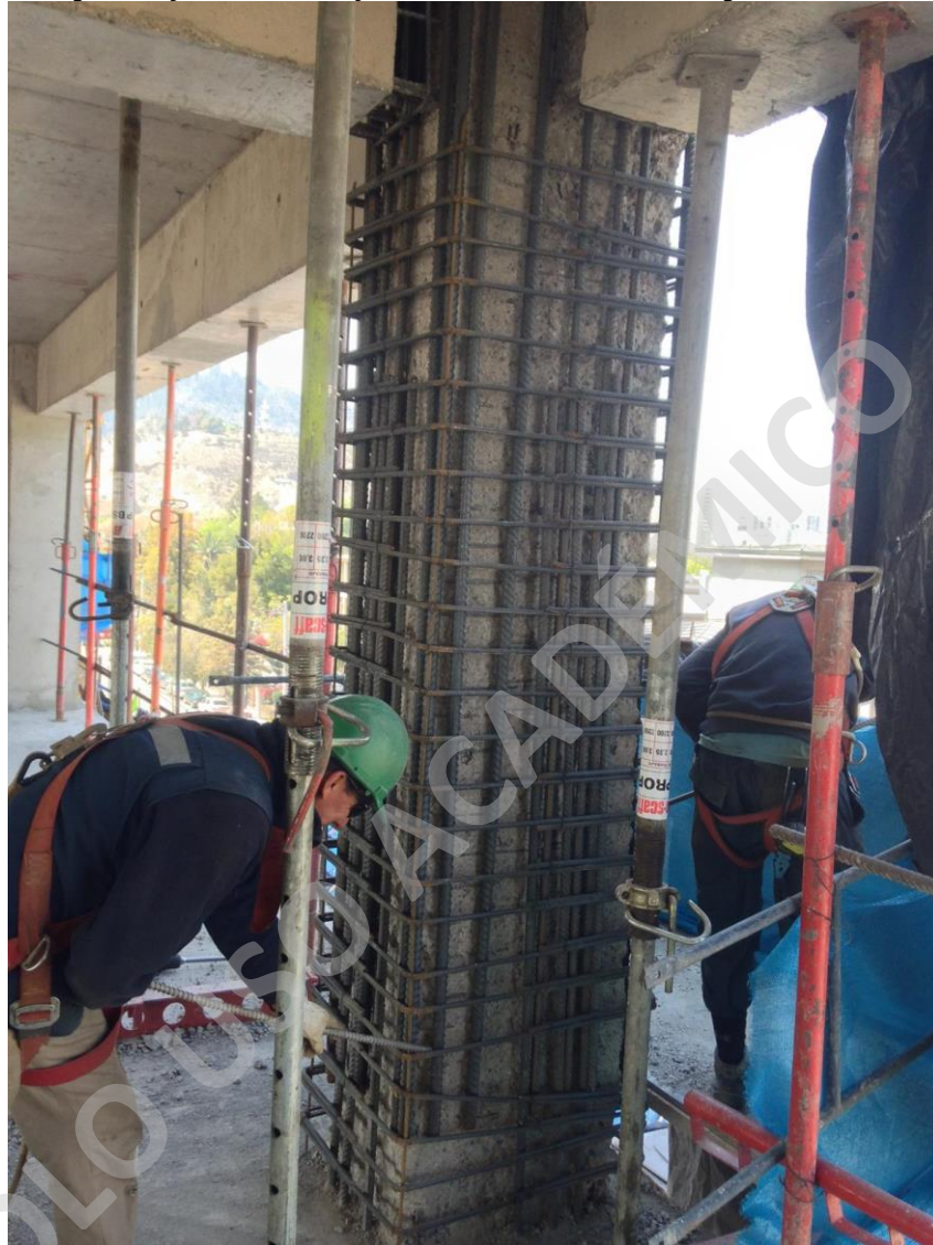
Imagen N° 28: Maestros en el 4° piso recibiendo los cabezales de la estructura en el pilar, ejes B/2 – Proyecto Centro Médico Independencia.
