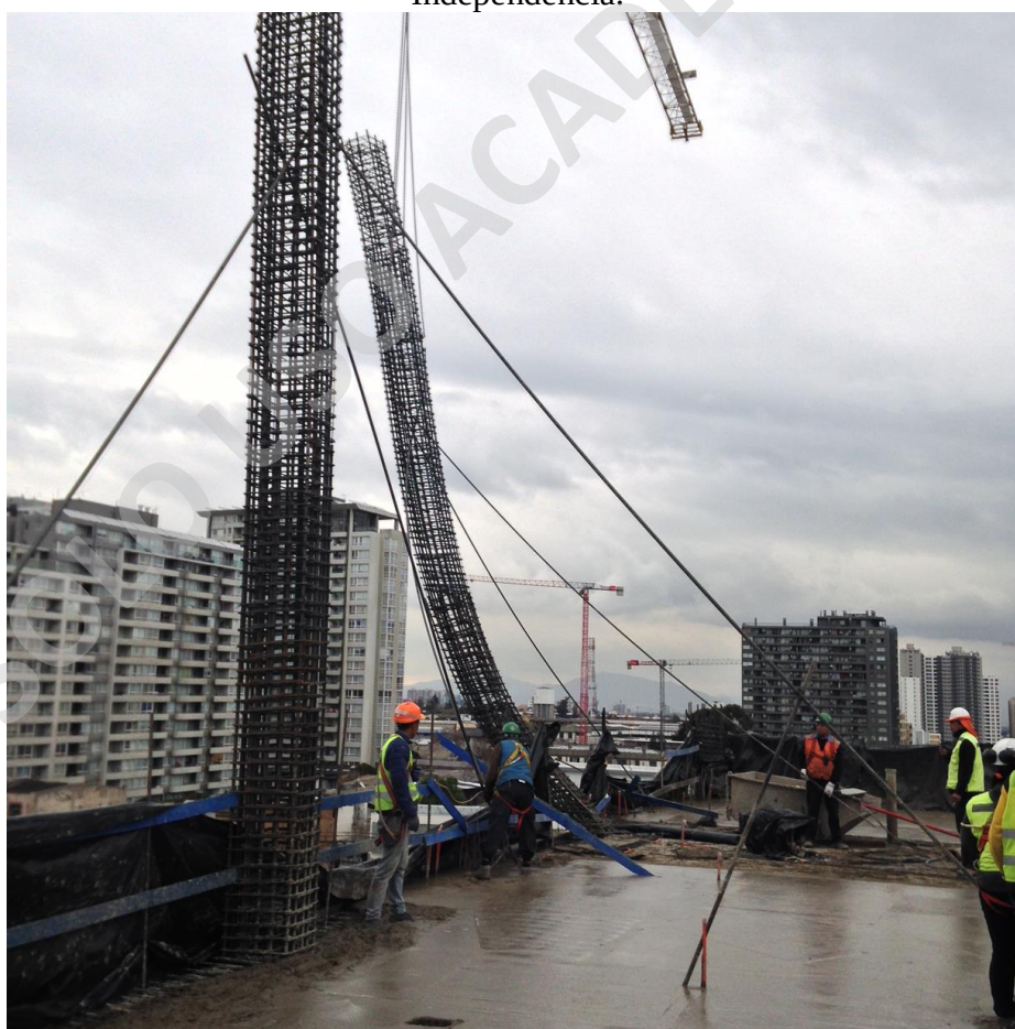
Imagen N° 9: Izaje del pilar en ejes B/2, 5° piso – Proyecto Centro Médico Independencia.
