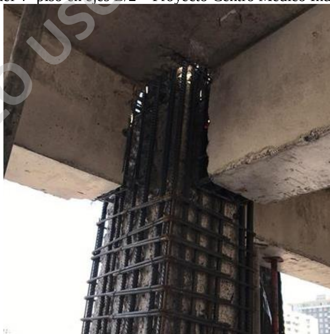
Imagen N° 27: Barras cabezales pasando entre medio de las armaduras de las vigas y la losa cielo del 4° piso en ejes B/2 – Proyecto Centro Médico Independencia.
