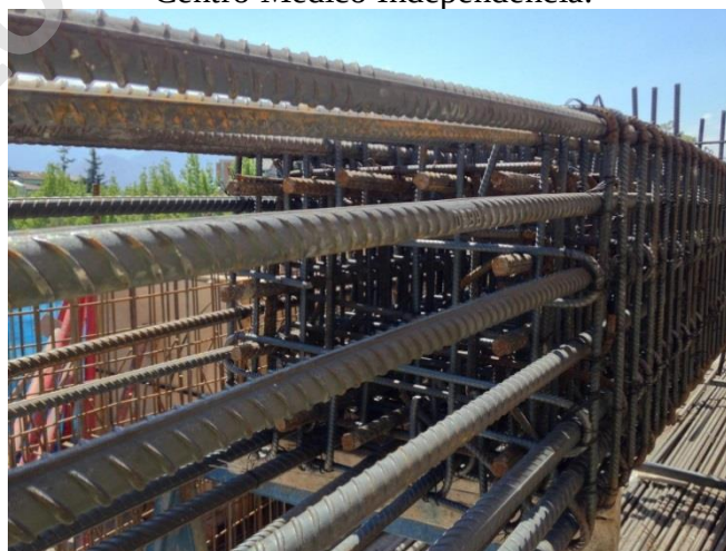
Imagen N° 21: Estructura pre armada para pilar en ejes B/2, pisos 4° al 6°, – Proyecto Centro Médico Independencia.
