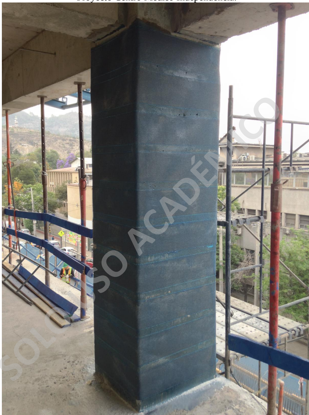
Imagen N° 40: Refuerzos de fibra de carbono instalados en pilar, ejes B/2, 4° piso – Proyecto Centro Médico Independencia.
