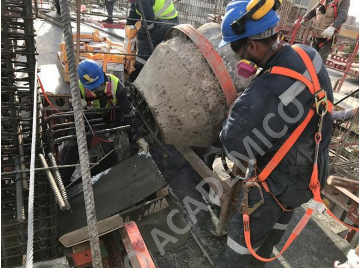
Imagen N° 33: Vertido de la mezcla desde la plataforma habilitada en 5° piso, ejes B/2 – Proyecto Centro Médico Independencia.
