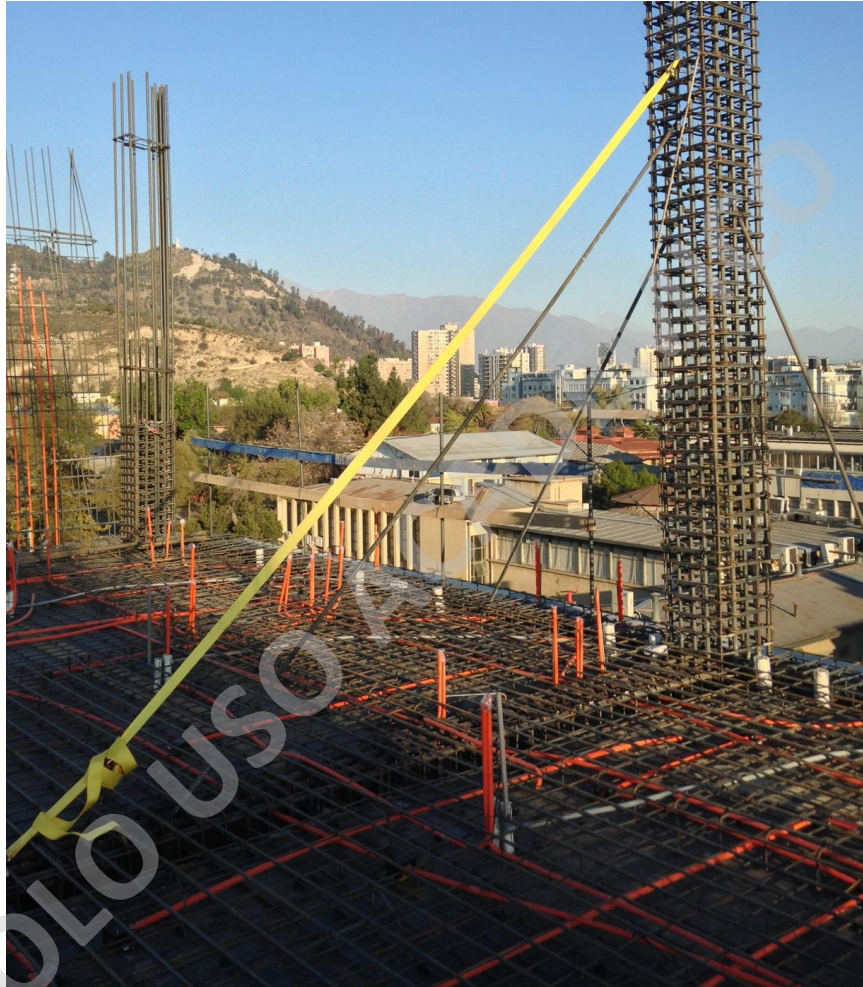
Imagen N° 47: Pilare de acero de refuerzo arriostrado con vientos y eslingas – Proyecto Centro Médico Independencia.
