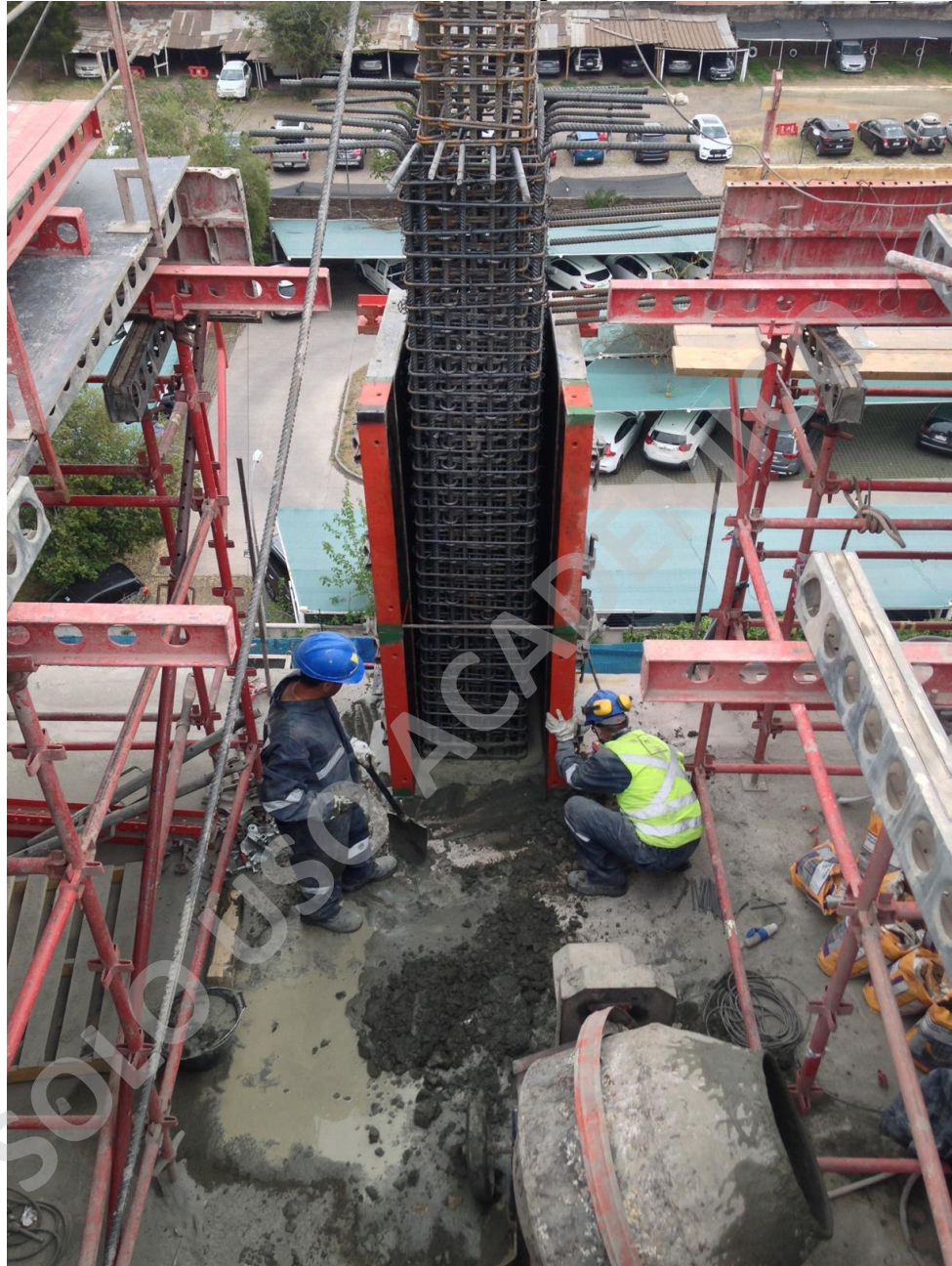
Imagen N° 34: Pilar llenado hasta el nivel de losa del 5° piso, ejes A/2 – Proyecto Centro Médico Independencia.
