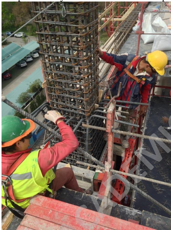
Imagen N° 35: Instalación de cuñas y chequeo del plomo del pilar en ejes A/2, nivel de cielo del 5° piso – Proyecto Centro Médico Independencia.
