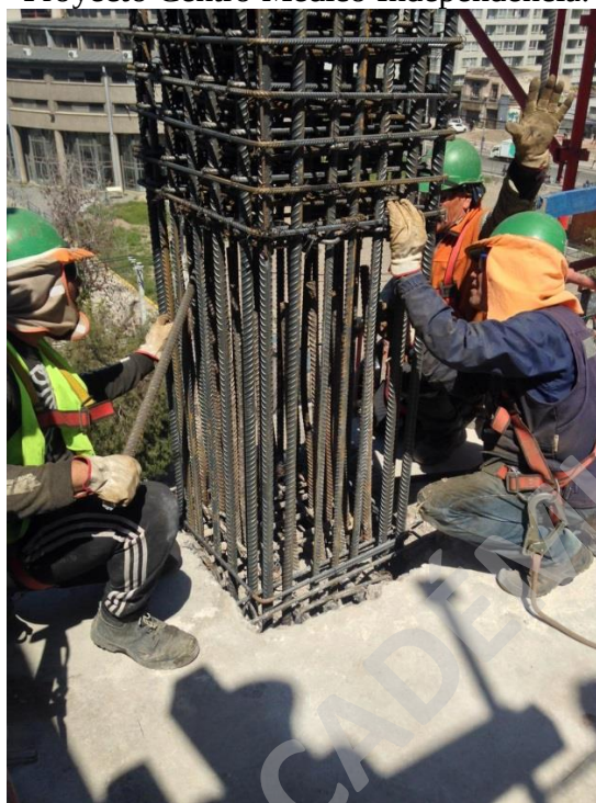
Imagen N° 26: Cuadrilla de maestros recibiendo la estructura en el 5° piso, ejes B/2 – Proyecto Centro Médico Independencia.
