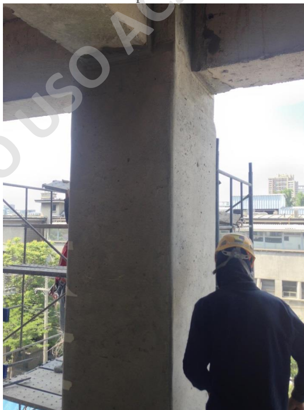
Imagen N° 39: Superficie pulida, pilar en ejes B/2, 4° piso – Proyecto Centro Médico Independencia.
