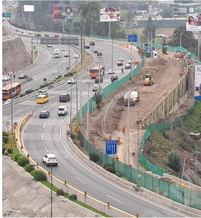
Ilustración 16 Trabajos en ejecución Ensanche Plataforma La Pirámide
