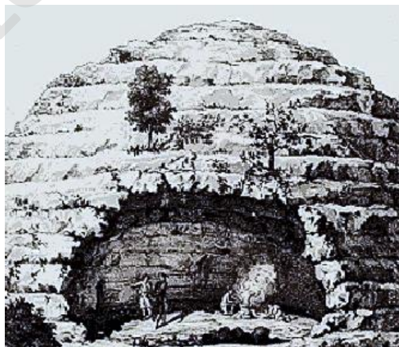
Ilustración 1 Perforación de túnel con fuego
