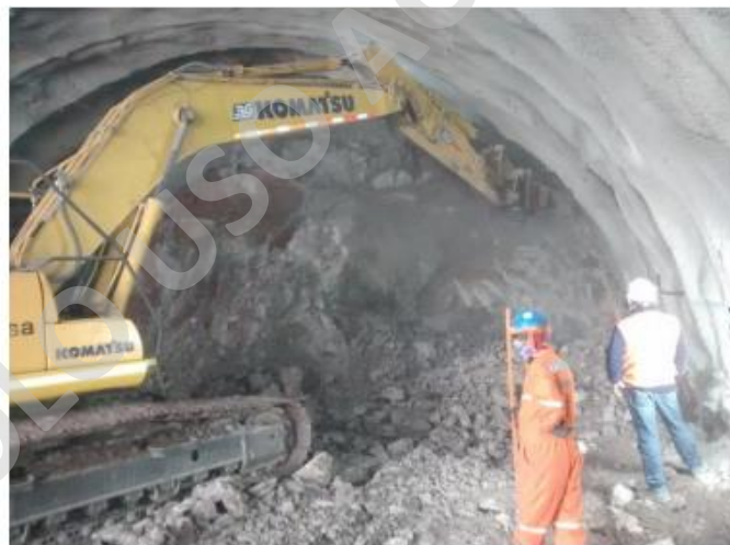
Ilustración 17 Trabajos en ejecución Túnel La Pirámide.
