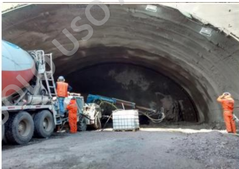
Ilustración 15 Excavación con maquinaria
