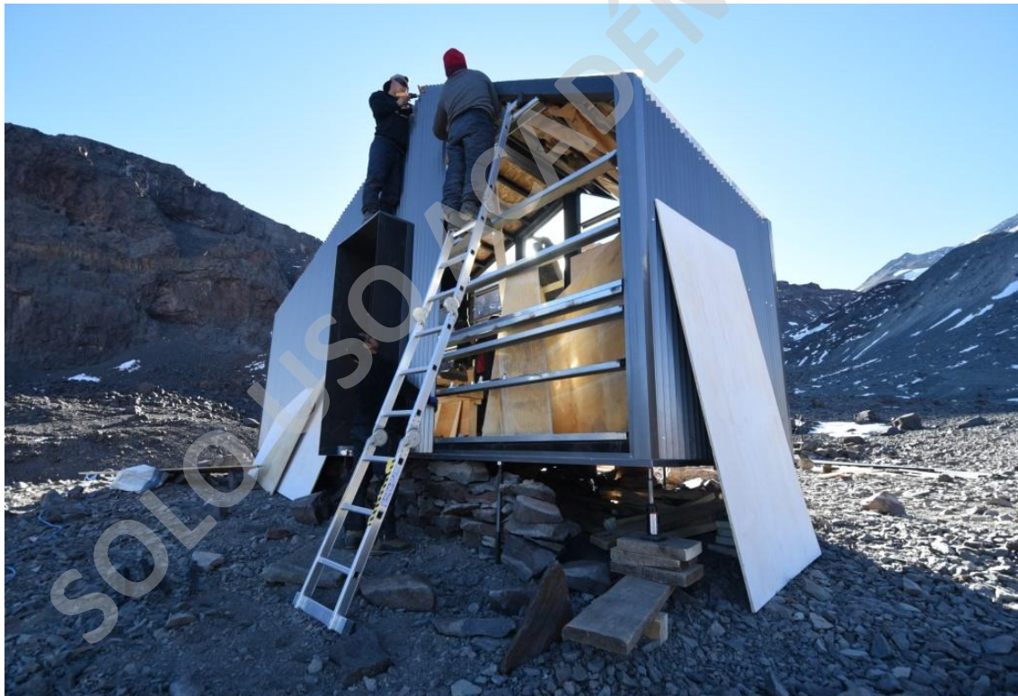
Imagen N° 31: Revestimiento, colocación de planchas de acero emballetado.
