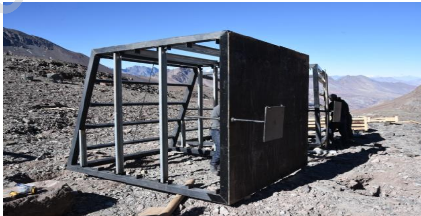
Imagen N° 27: Platinas de acero, base de las fundaciones.
