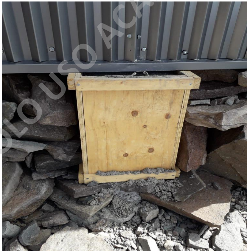
Imagen N° 29: Moldaje de hormigón en función de estabilidad.
