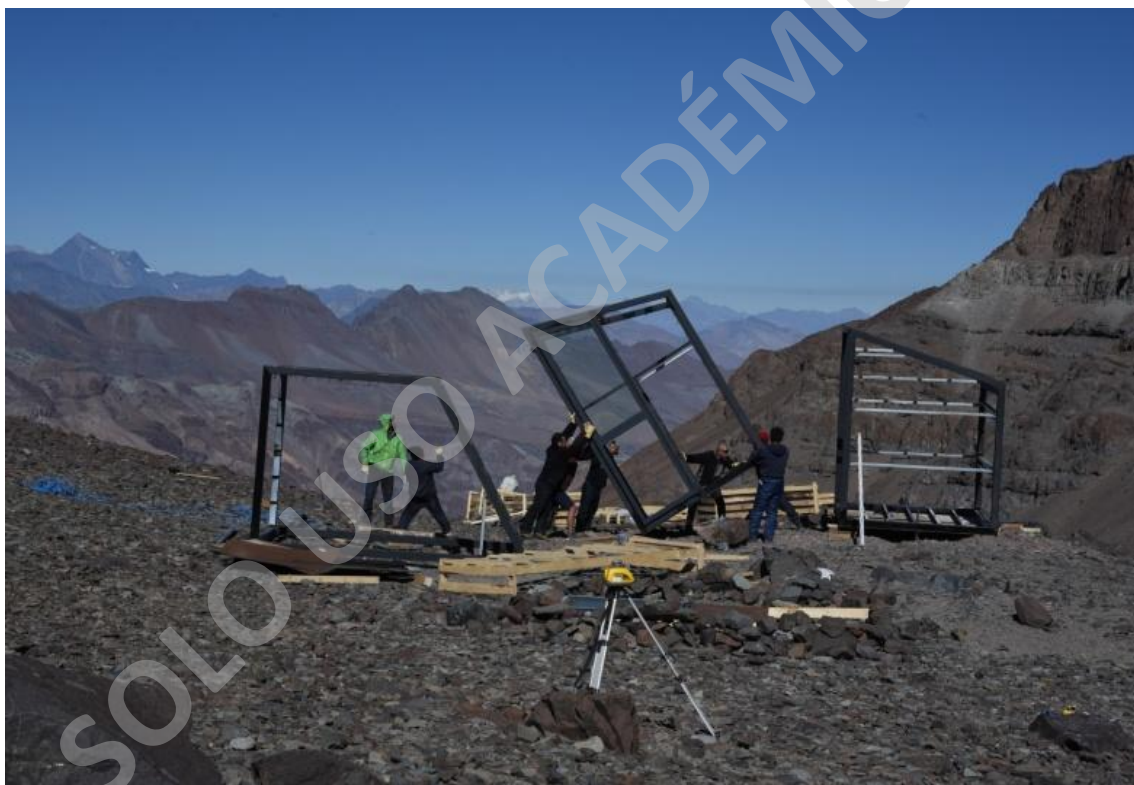
Imagen N° 23: Acoplamiento de módulos.
