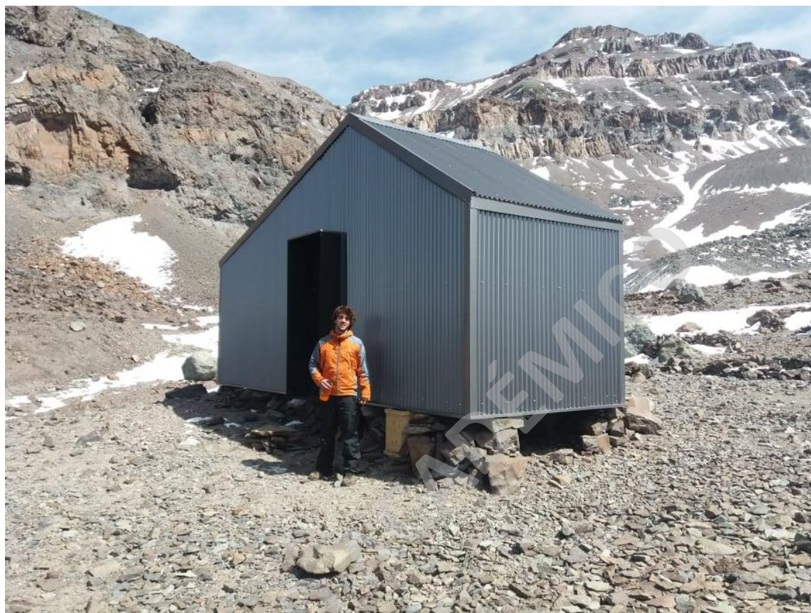
Imagen N°50: Vista completa del refugio e hitos naturales.
