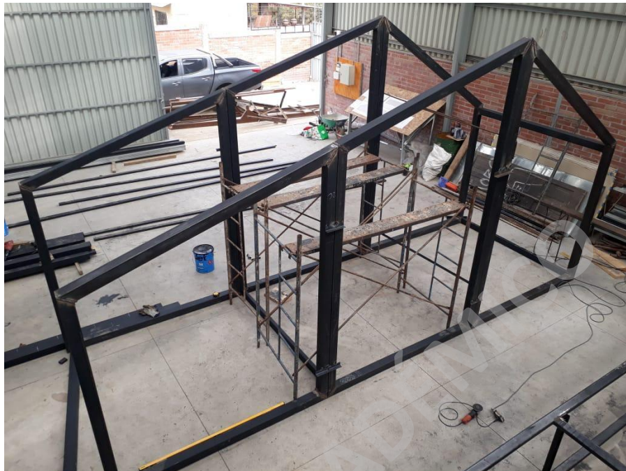
Imagen N° 17: Prueba de unión y estructuración en base a acero.
