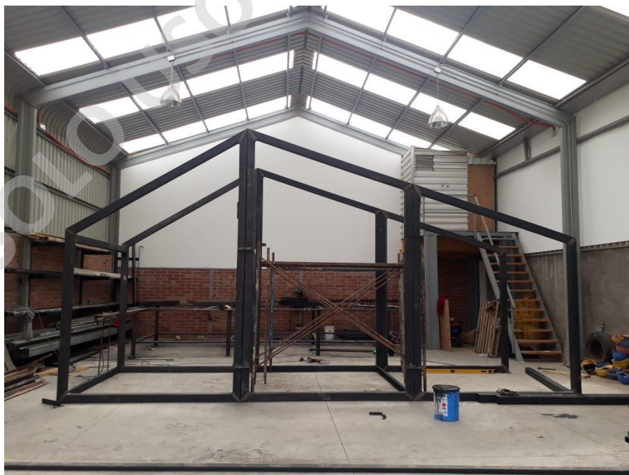
Imagen N° 18: Prueba de unión y estructuración.
