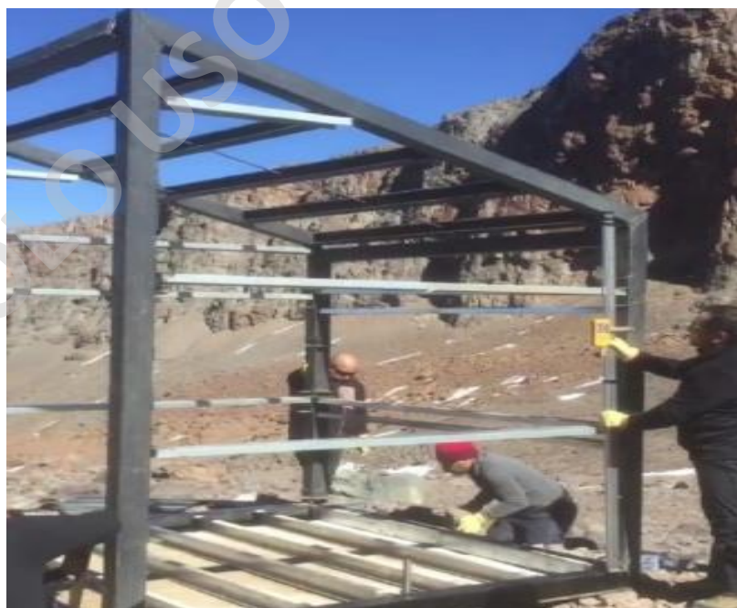
Imagen N°26: Nivelación de módulos.
