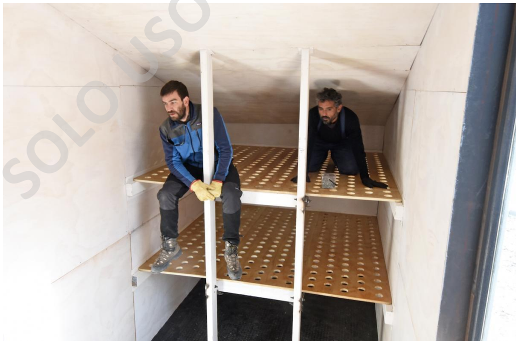
Imagen N° 35: Interior refugio, estructura de camarotes.
