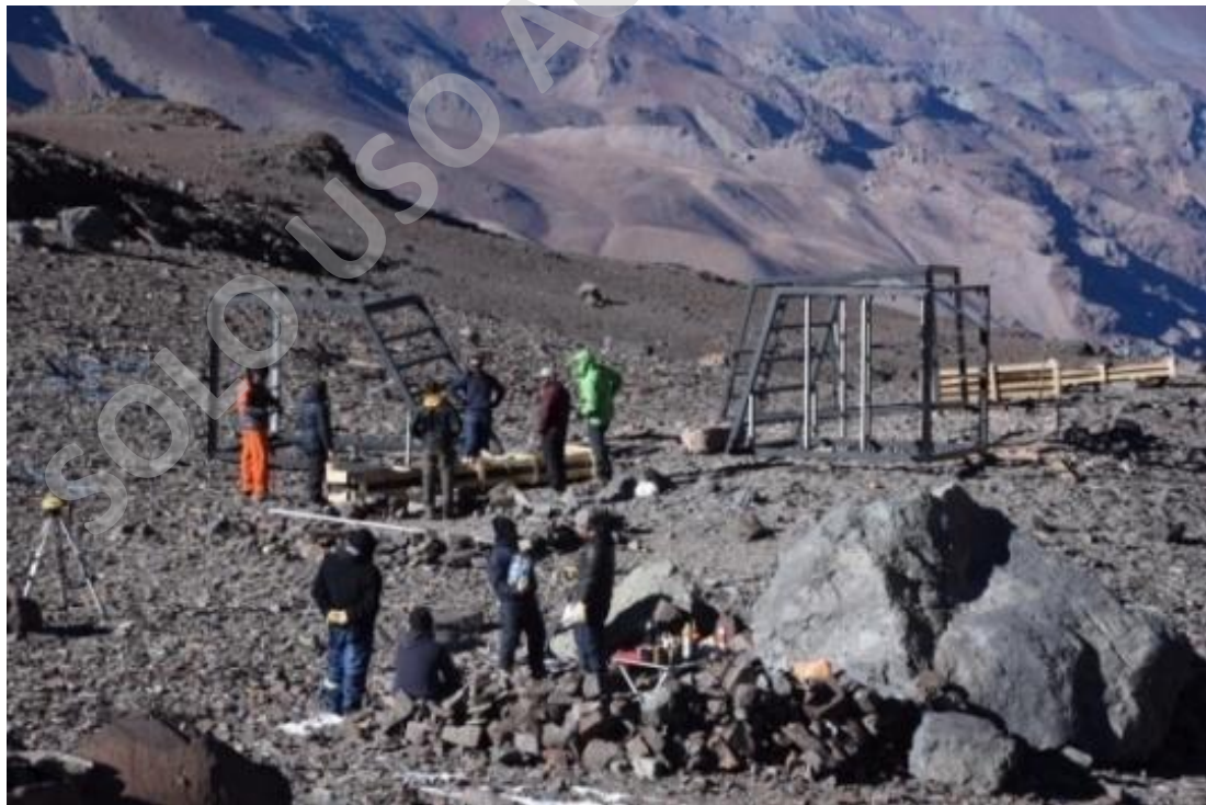
Imagen N° 24: Logística y acopio de llegada de material.
