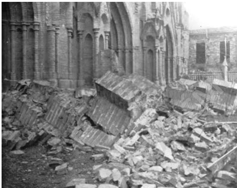
Figura 3 .- Destrucción Basílica del Salvador sismo 1985
