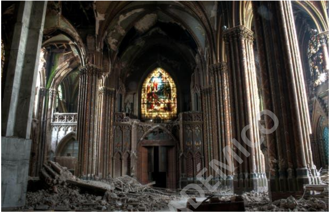
Figura 4 .- destrucción basílica del salvador sismo 2010
