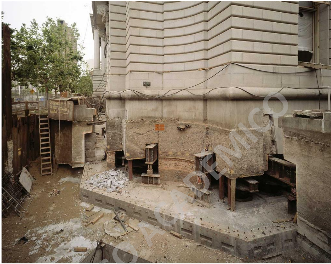
Figura 14.- Ingreso de vigas bajo la estructura
