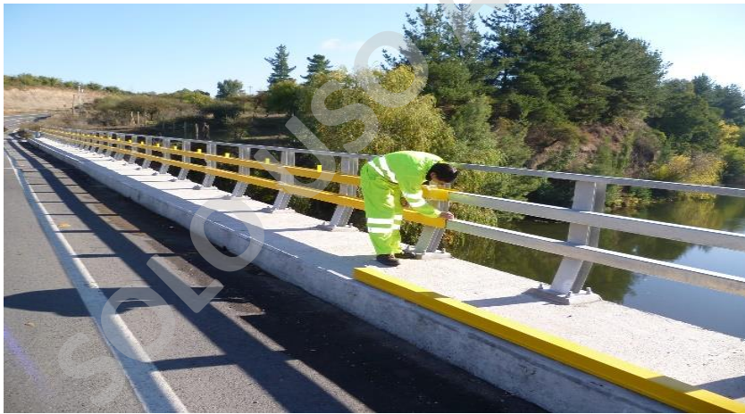
Ilustración 10: PLACA AMARILLA en su versión defensa para puentes
