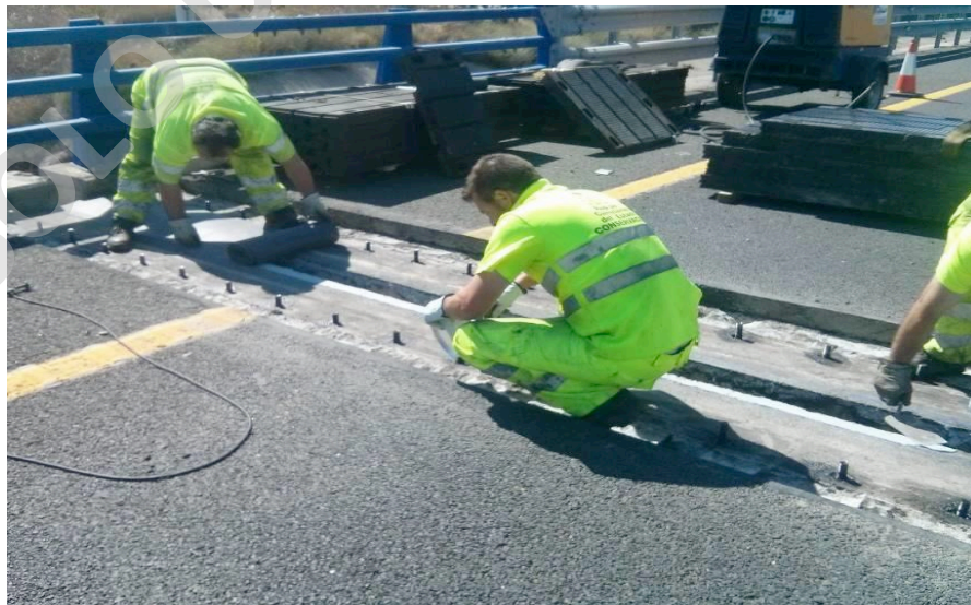
Figura 21: Colocación de la banda
