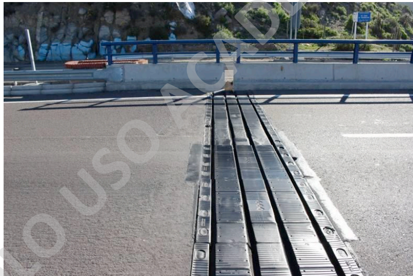
Figura 19: Junta tipo banda de caucho plegada en bloques.
