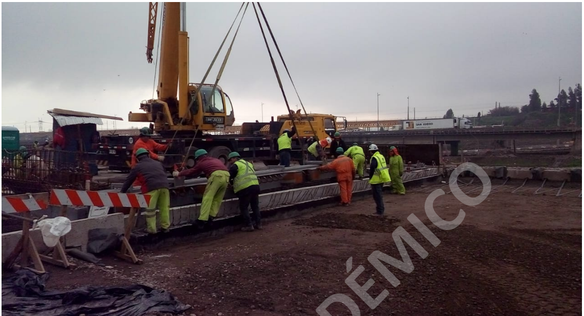
Figura 17: Instalación Junta de dilatación Nuevo Puente Maipo.
