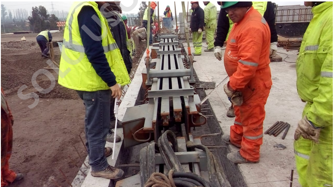
Figura 18: Instalación Junta de dilatación Nuevo Puente Maipo.
