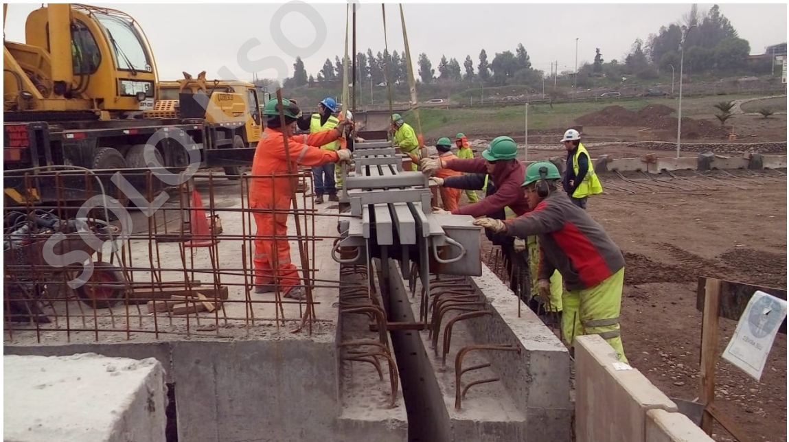
Figura 16: Instalación Junta de dilatación Nuevo Puente Maipo.
