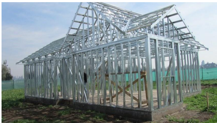
Figura 10: Vivienda Realizada En Metalcom.
