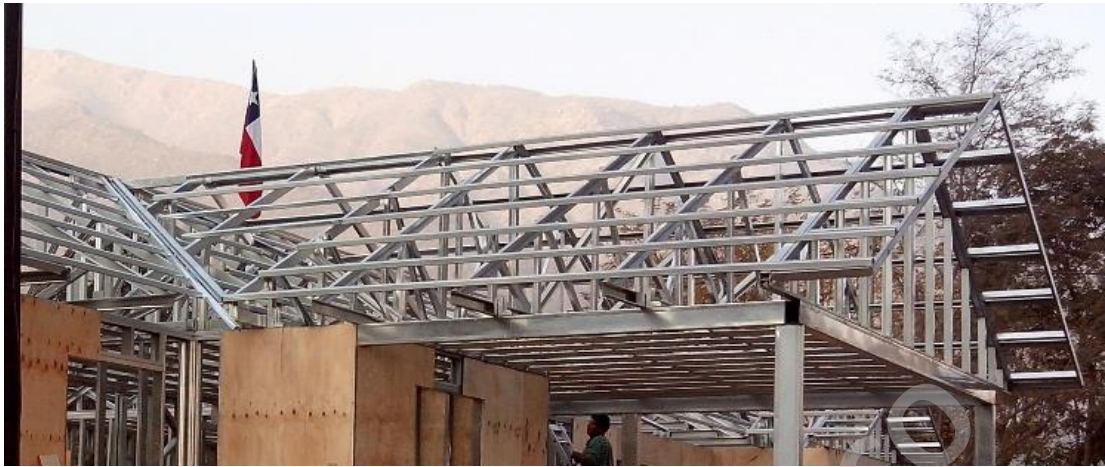
Figura 21; Cercha de Metalcom Montada.
