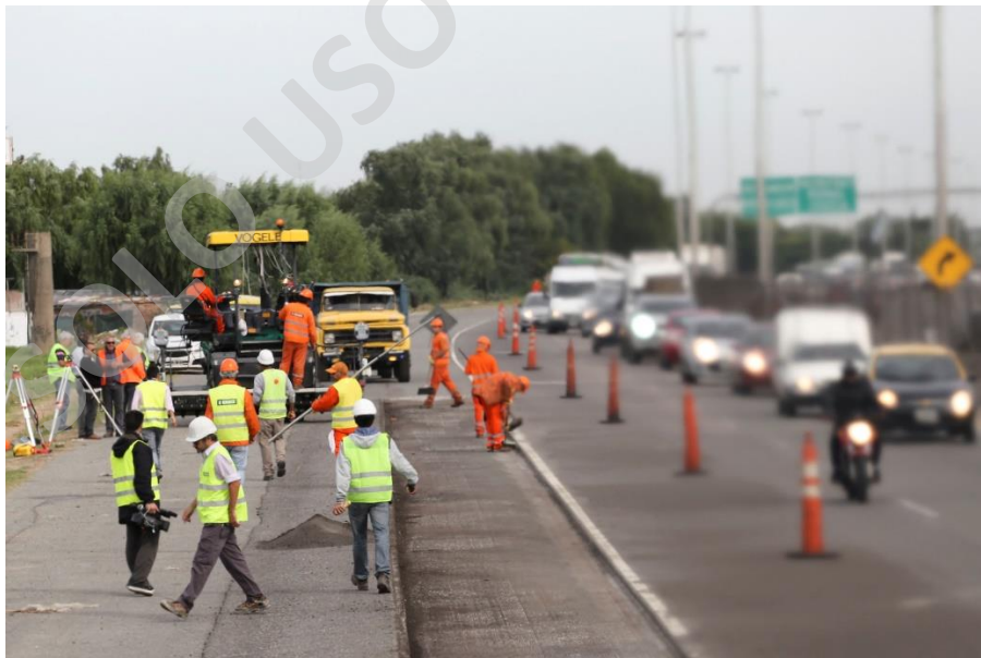
Imagen 4: Modificación de Carretera
