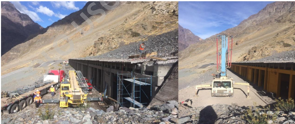
Figura 4. 6 Reparación de Cobertizos, caso estudio ruta 60 CH
