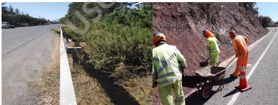
Figura 5. 4 Limpieza y mantención de bermas, caso de estudio contrato global San Felipe
