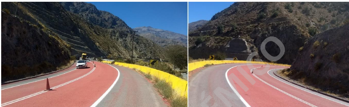
Figura 4. 5 Reparación Pavimento antideslizante, caso estudio ruta 60CH
