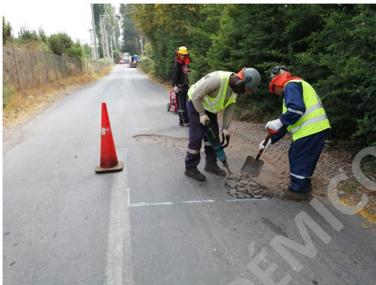
Figura 5. 3 Preparación de Bacheo en caliente, caso de estudio contrato global San Felipe
