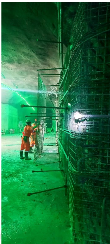
Instalación de segunda malla.
