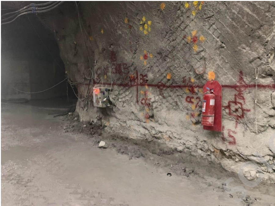
Fortificación existente. Malla bizcocho, perno helicoidal, shotcrete.
