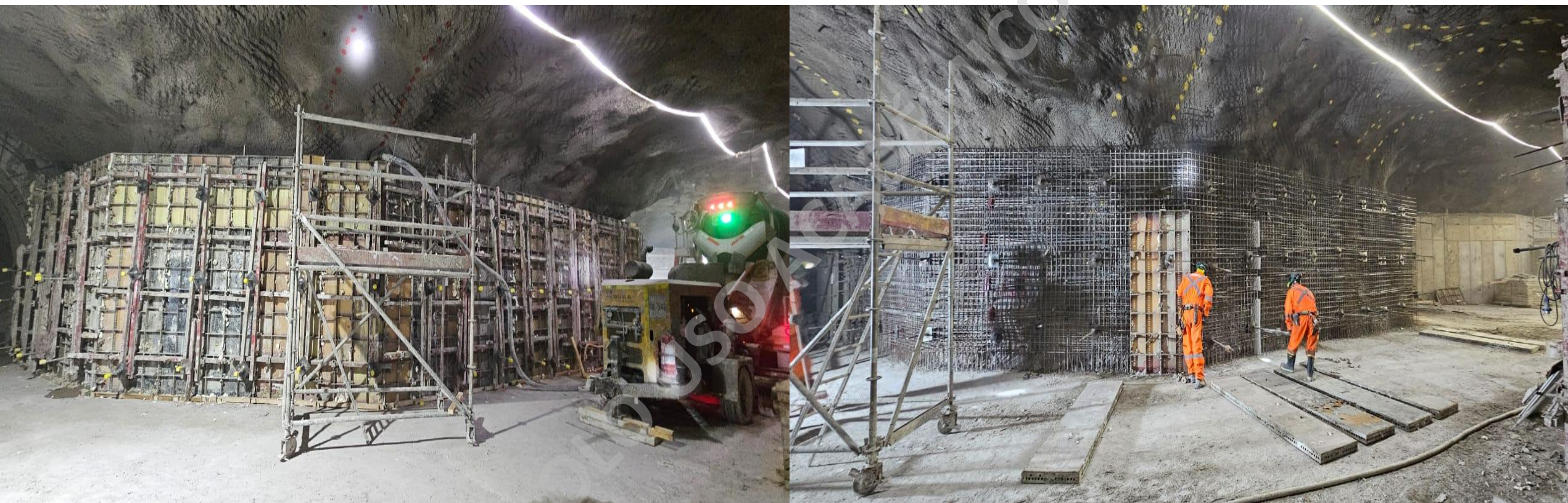
Instalación de moldaje y vaciado de hormigón.
