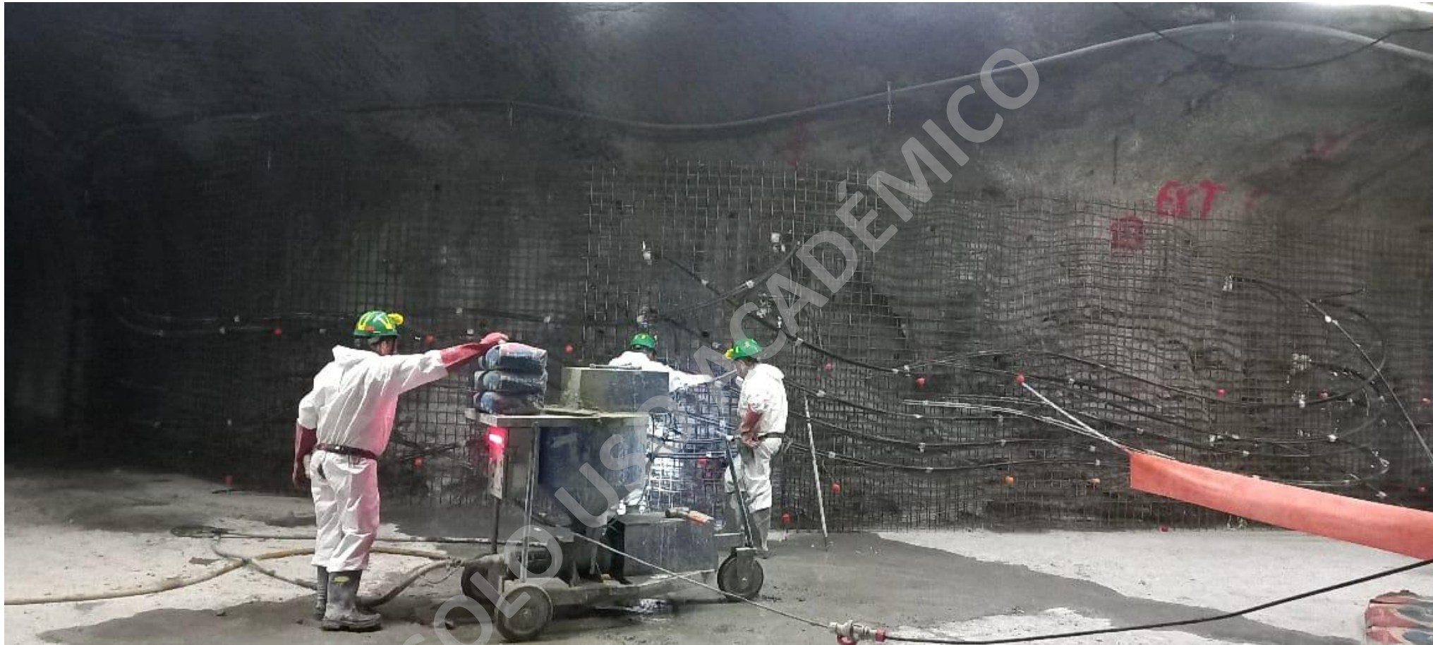
Instalación y lechado de pernos cables y helicoidales.
