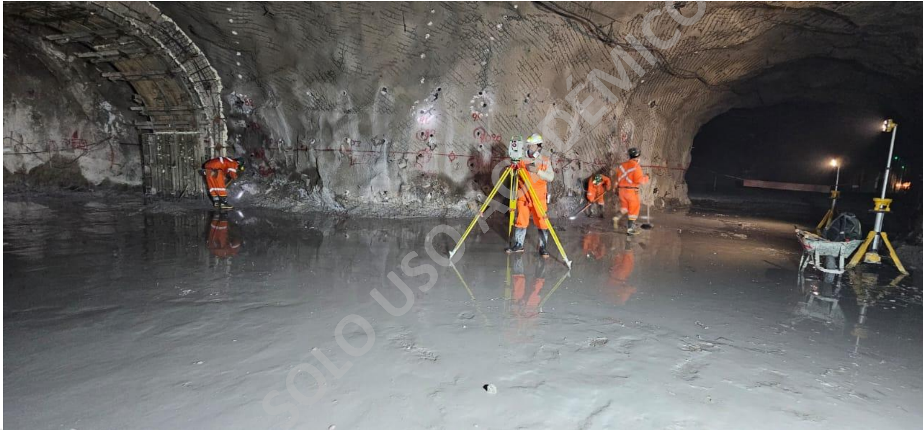
Chequeo de área entregada con topografía.
