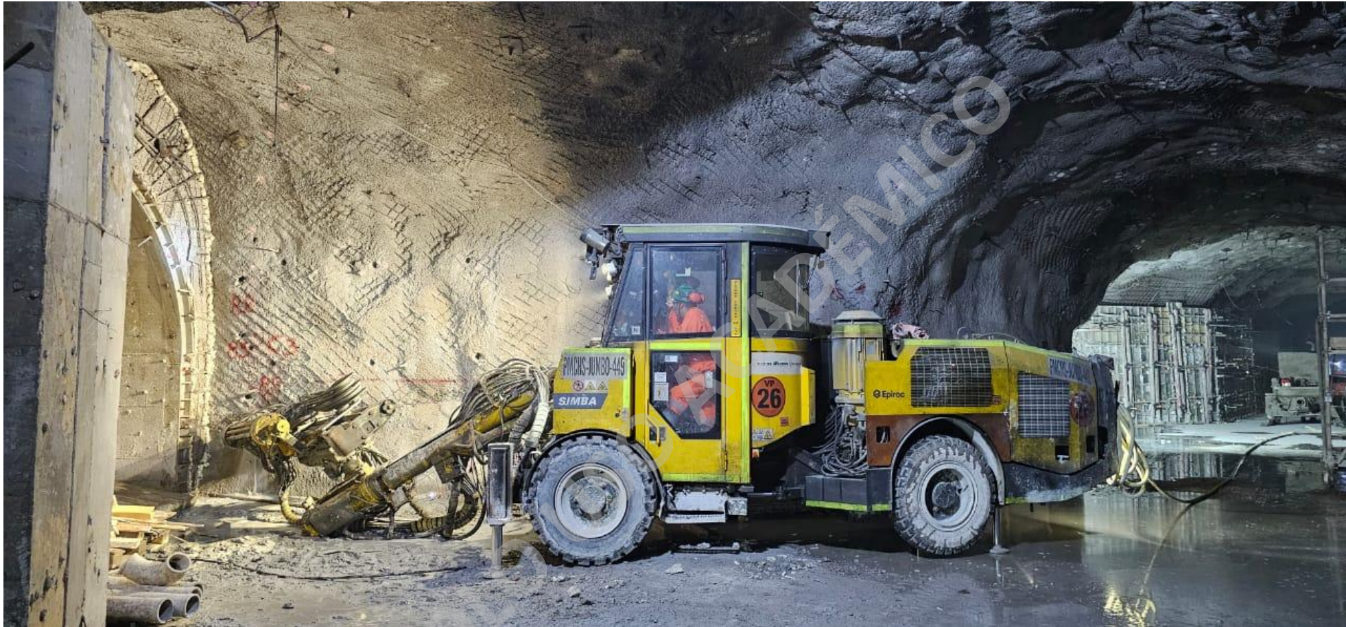
Perforación de pernos helicoidales y pernos cables.
