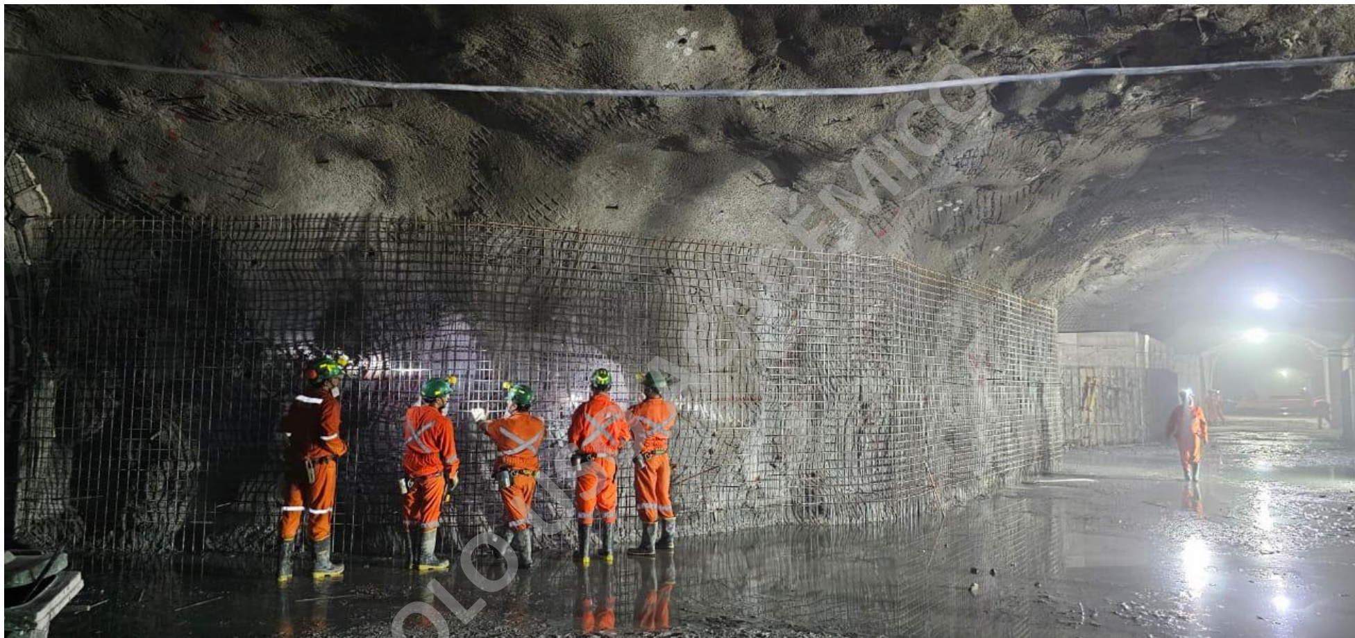
Instalación de primera malla.
