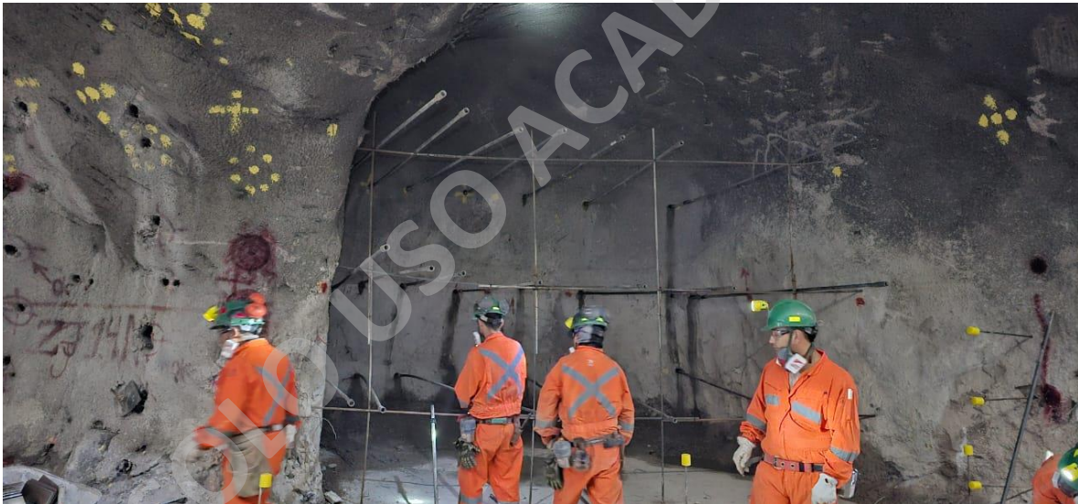
Figura K.1 sobre excavación de 5 metros de anomalía.
