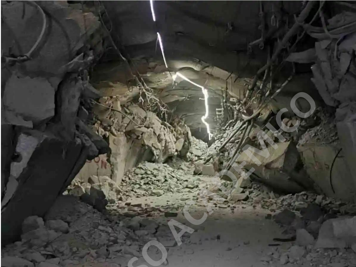
Figura H.1 Derrumbe en mina Chuquicamata
