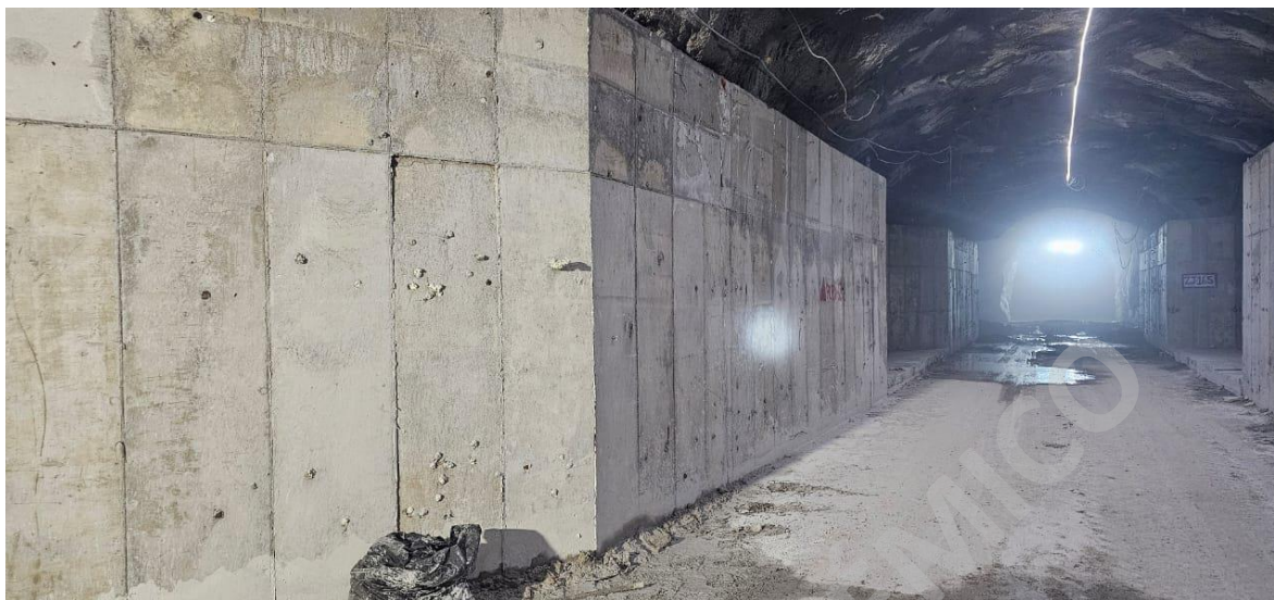
Figura K.3 muro especial terminado.
