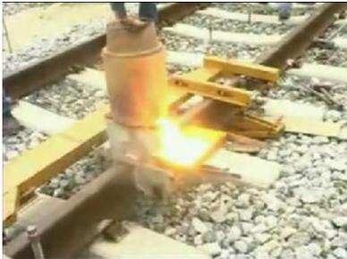
*Foto 76.-Fundición para soldadura Aluminotermica.*
