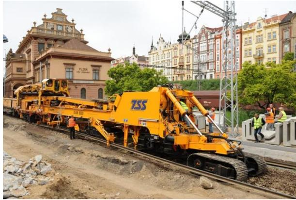
Foto 82.-SVM 1000. Compactación balasto, colocación durmiente y riel.
