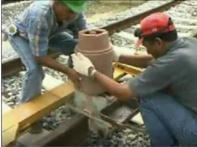
*Foto 75.- Colocación caldero de soldadura Aluminotermica.*
