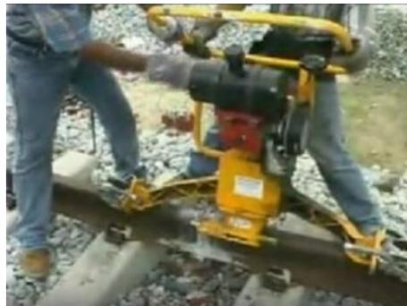
*Foto 77.-Pulidora de rieles, posterior a soldadura Aluminotermica.*
