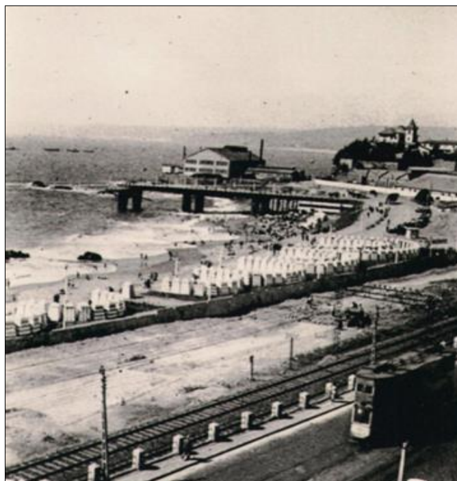
(Fotografía 5) Muelle e instalaciones de Lever & Murphy en Caleta Abarca. Fuente: Informe etapa 1 GHD, diciembre 2012
