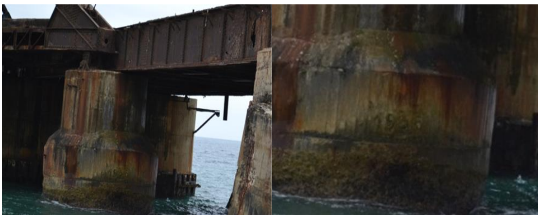
(Fotografía 11) Tercera pila contada desde la orilla posee una leyenda de construcción del año 1935. Fuente: Fotografía realizada por la empresa GHD el 12.11.11.
