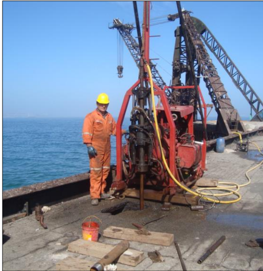
(Fotografía 22) Ejecución sondaje 2 realizado por Bordemar. Fuente: Informe etapa 1 GHD, diciembre 2012
