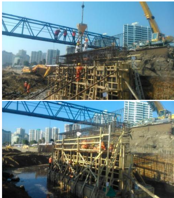
(Fotografía 38) Moldaje muro estribo, Fuente: elaboración propia, noviembre 2016
