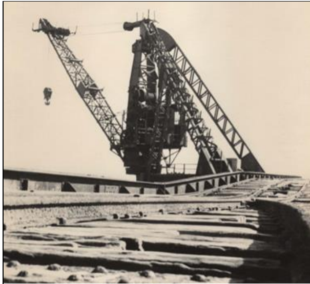
(Fotografía 9) Se observa la pendiente que tenía el muelle para el mejor deslizamiento de los carros de trenes de carga. En la actualidad se aprecia totalmente nivelado. Fuente: Informe etapa 1 GHD, diciembre 2012
