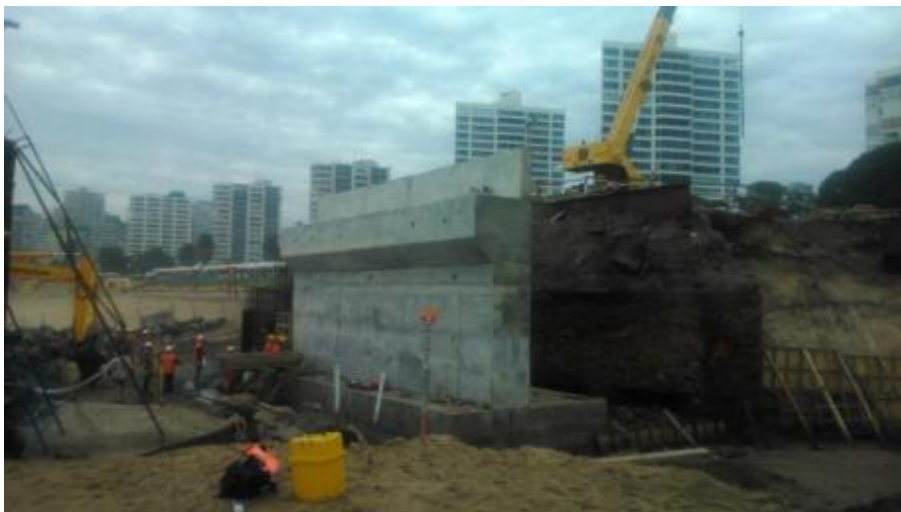
(Fotografía 39) Muro estribo, Fuente: Elaboración propia, diciembre 2016
