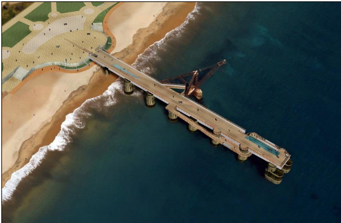
(Fotografía 32) Vistas general alternativa 2. Fuente: Informe etapa 2-rev B GHD, mayo 2013
