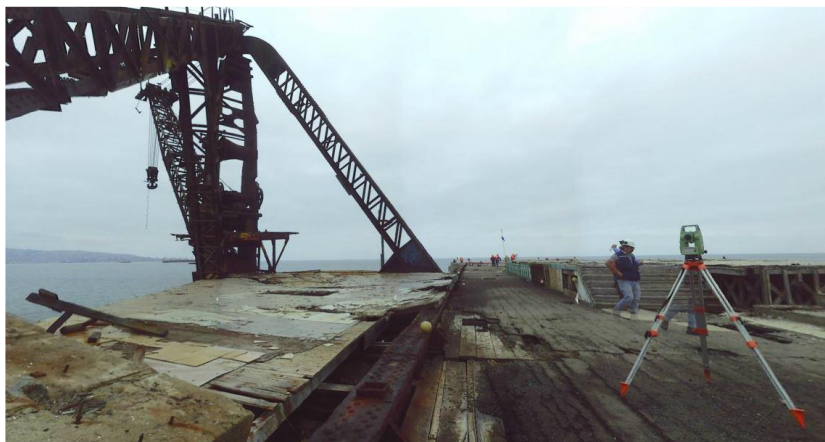
(Fotografía 48) Foto de levantamiento, Fuente: Escaneo Grúa, REstudio, marzo 2015.
