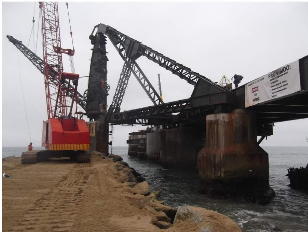
(Fotografía 49) Montaje Grúa, Fuente: DOP, Julio 2016.
