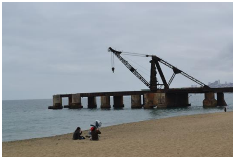
(Fotografía 7) El Mercurio de Valparaíso en el año 1895 informa que la grúa y la estructura metálica son traídas desde Europa, se constata que en los dos años siguientes se construyen las pilas de la estructura de la grúa. Fuente: Informe etapa 1, Imagen, noviembre 2011
