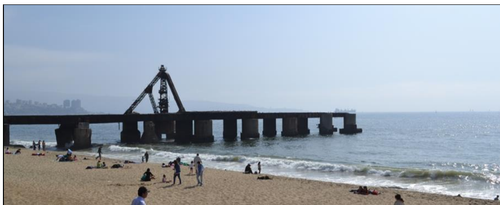
(Fotografía 28) Vista norte Muelle Vergara, Fuente: Informe etapa 1 GHD, diciembre 2012
