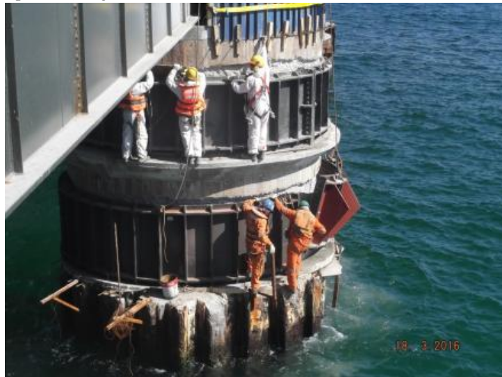
(Fotografía 45) Montaje de anillos metálicos, Fuente: Presentación DOP noviembre 2016
