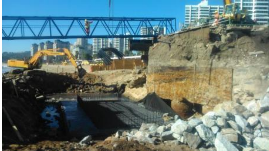
(Fotografía 37) Armadura muro estribo, Fuente: elaboración propia, noviembre 2016
