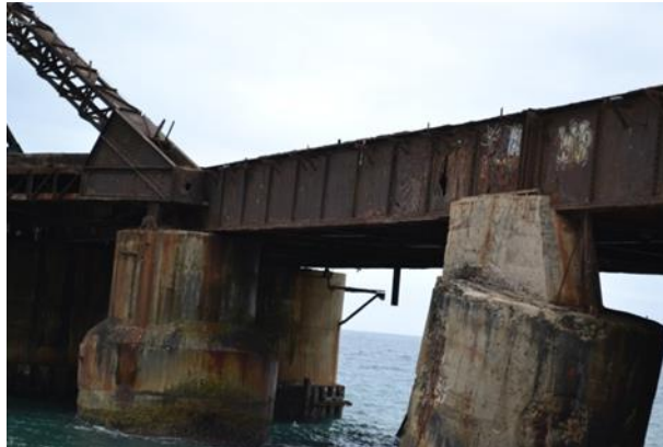
(Fotografía 15) Se puede apreciar que los trabajos de nivelación se realizados en el año 1986, confirman la estabilidad de la pila asentada. Fuente: Fotografía realizada por la empresa GHD 12.11.11.
