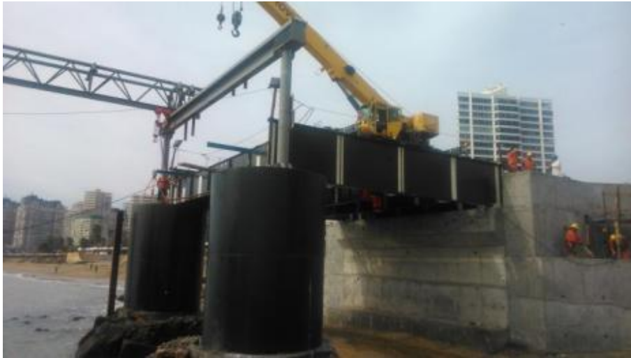
(Fotografía 41) Montaje vigas I al A, Fuente: Presentación DOP noviembre 2016
