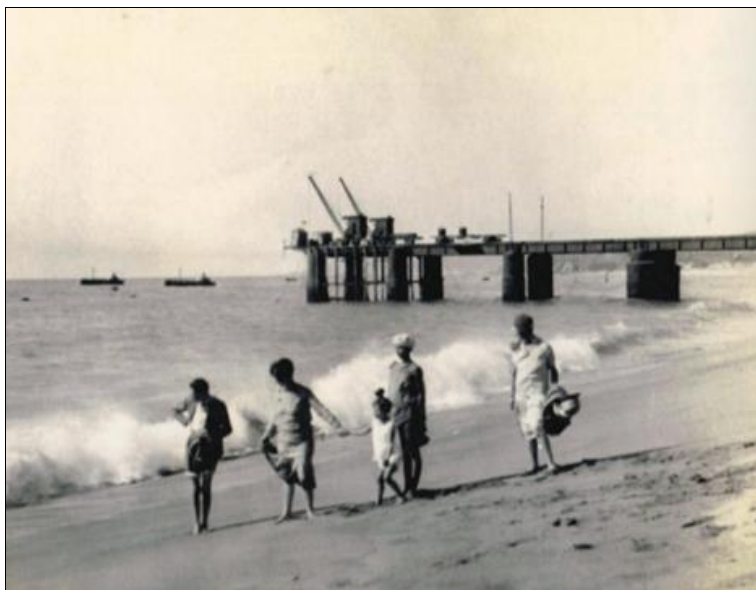
(Fotografía 6) Imagen del muelle antes que se instalara la grúa, solo se habían instalado ocho pilas en el año 1893. Fuente: Informe etapa 1 GHD, diciembre 2012
