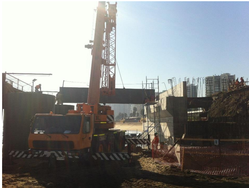
(Fotografía 40) Montaje vigas I y J, Fuente: Elaboración propia, Julio 2015
