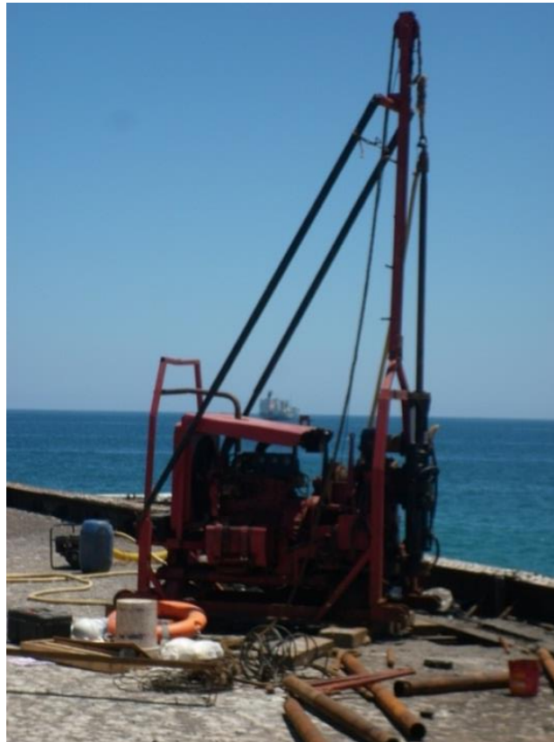
(Fotografía 23) Ejecución sondaje 4 realizado por Bordemar. Fuente: Informe etapa 1 GHD, diciembre 2012
