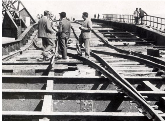
(Fotografía 29) Vista tablero muelle. Fuente: Informe etapa 1 GHD, diciembre 2012
