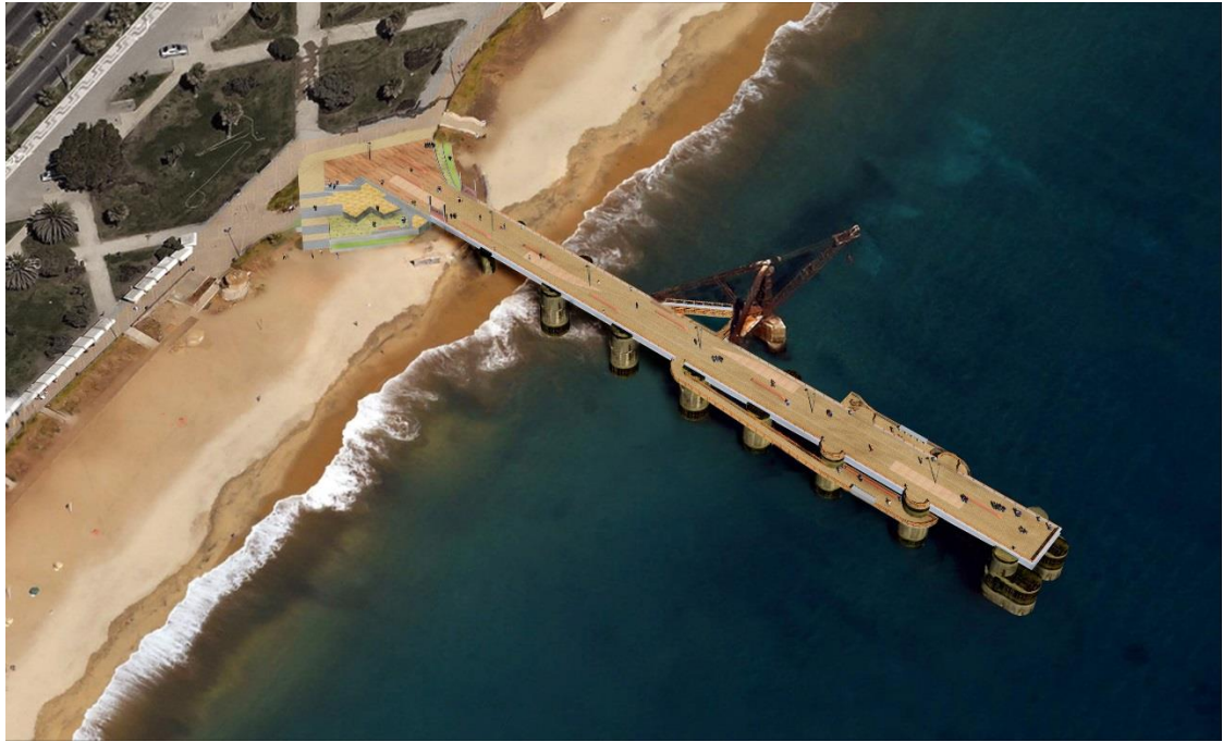
(Fotografía 34) Vistas generales alternativa seleccionada. Fuente: Informe etapa 3 imágenes 3D GHD, noviembre 2013
