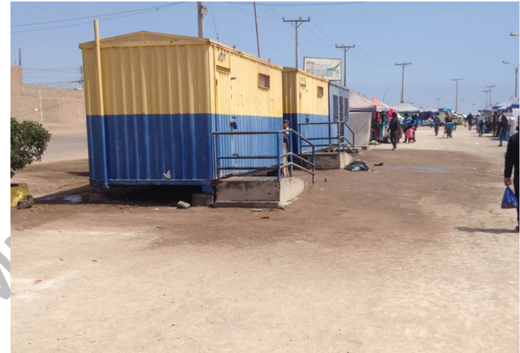
Imagen 1: Servicios Sanitarios existentes Fuente: Banco de imágenes propias
