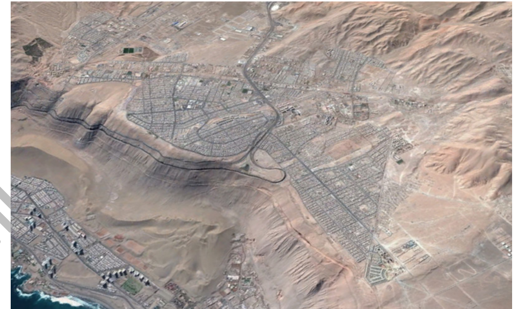
Imagen: Emplazamiento general Alto Hospicio Fuente: Elaboración propia.
