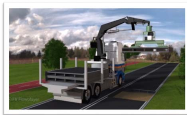
Figura N°10 – Sistema de montaje Plastic Road.
