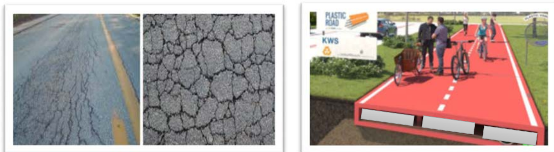
Figura N°64 – Ahuellamiento v/s sistema en bloques.
