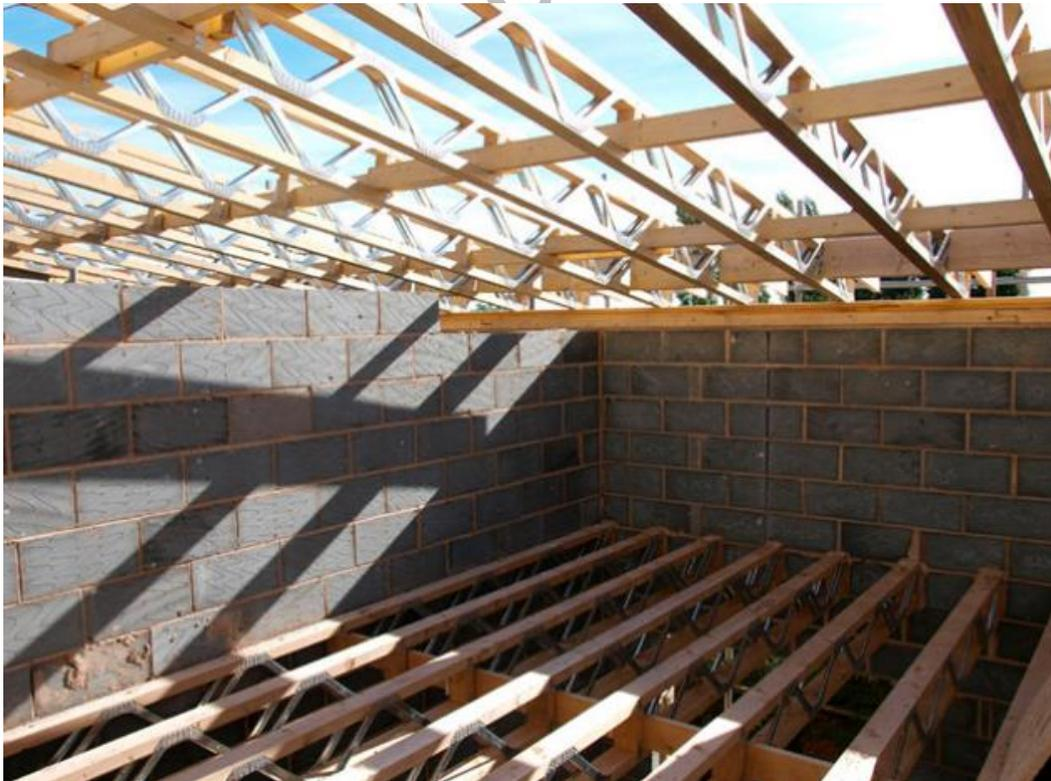
*Ilustración 7 – entramado de vigas mixtas pt2*
