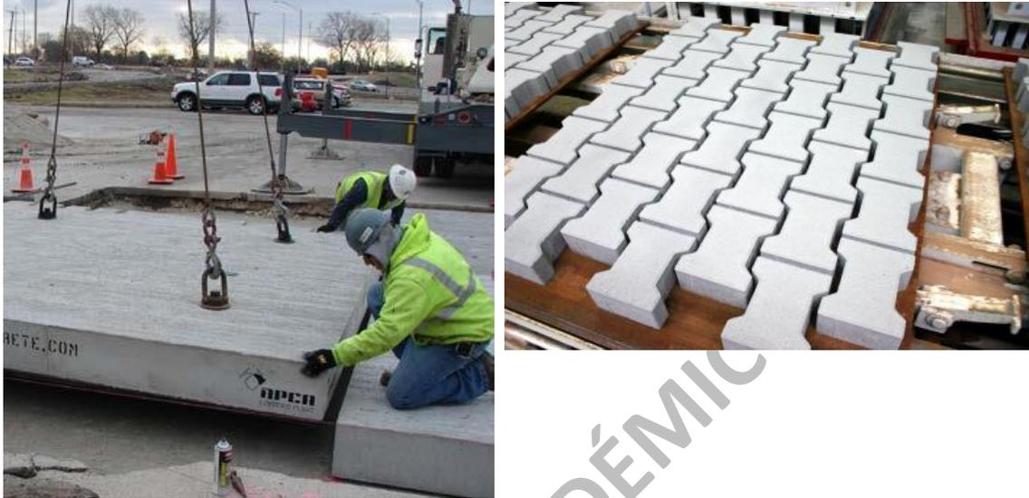
Ilustración 15 - instalación de losa para pavimento de alto tránsito y adoquines prefabricados
