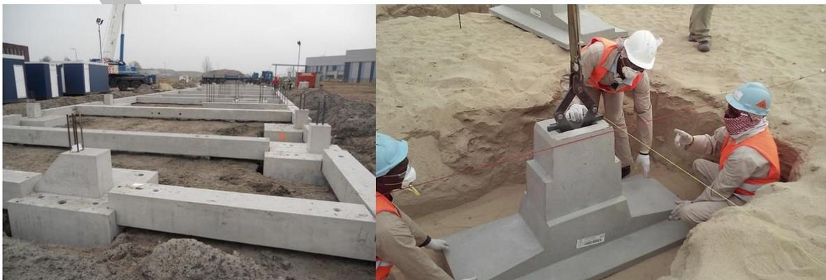
*Ilustración 11 – Cimientos prefabricados*
