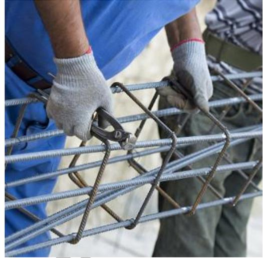
*Ilustración 19 - enfierradura de un pilar*
