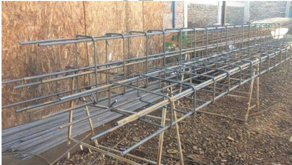
*Ilustración 20 - Viga pre armada*
