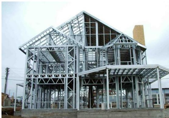
*Ilustración 18 - Vivienda completamente edificada con METALCON®*
