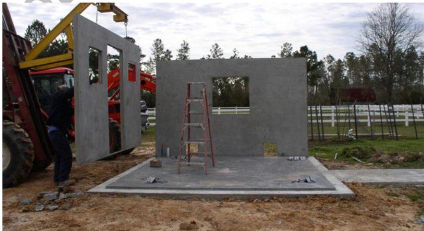
Ilustración 16 – instalación muro perimetral de una bodega
