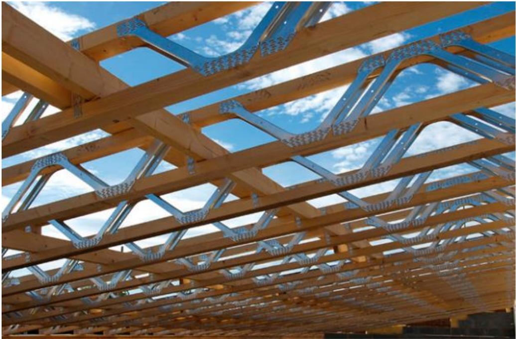
*Ilustración 6 – Entramado de vigas mixtas*
