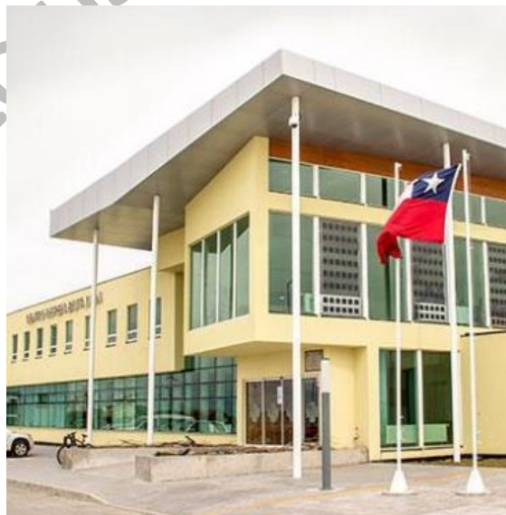
Hospital de Punta Arenas
