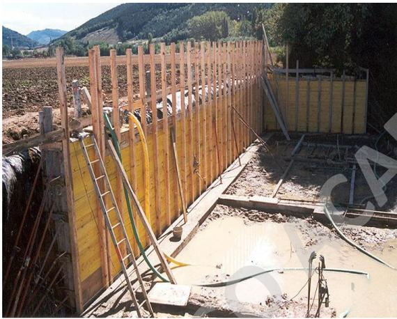
**Figura 4. 2 ESCOFRADOS DE TABLAS.** Fuente: [www.aridostie.cl](http://www.aridostie.cl)
