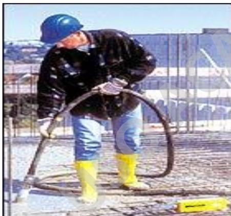
Figura 7. 1 VIBRADO DE HORMIGON. Fuente: [www.ich.cl](http://www.ich.cl)
