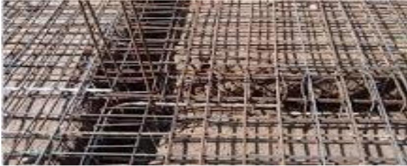
**Figura 10. 1 ENFIERRADURA DE LOSA.** Fuente: [www.ich.cl](http://www.ich.cl)
