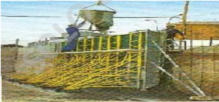
Figura 10. 5 VACIADO DE HORMIGON EN MUROS. Fuente: [www.abrosonline.com](http://www.abrosonline.com)
