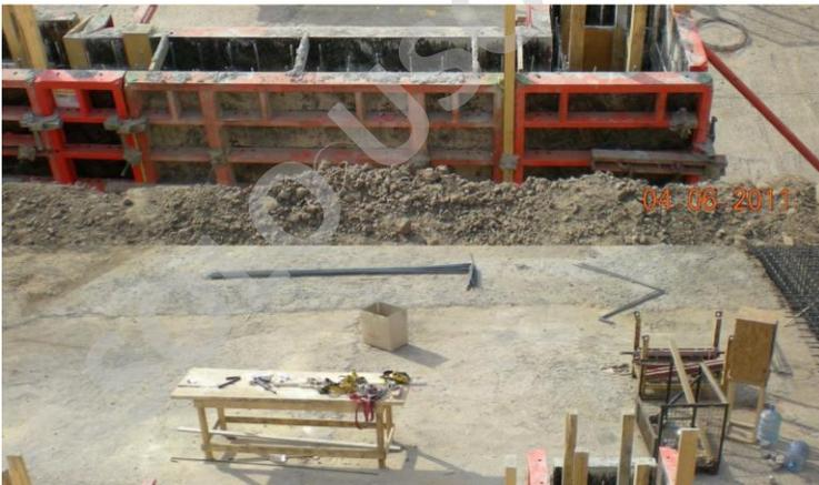
**Figura 3. 3 MAQUETA DE PRUEBA FUNDACIONES. Fuente: [www.ich.cl](http://www.ich.cl)**
