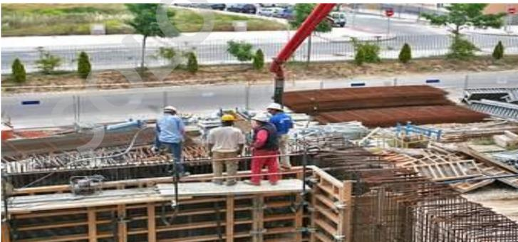
**Figura 10. 7 VACIADO DE HORMIGON BOMBEADO. Fuente: abrosoline.com**
