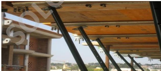
**Figura 4. 1 ESCOFRADOS DE MADERA. Fuente: [www.ich.cl](http://www.ich.cl)**
