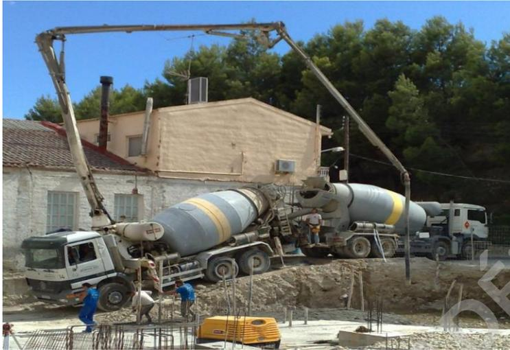
Figura 3. 10 BOMBEADO DE HORMIGON. Fuente: [www.aridostie.cl](http://www.aridostie.cl)
