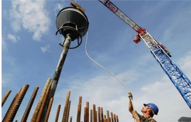
Figura 6. 1 VACIADO DE HORMIGON CON CAPACHO. Fuente: [www.ich.cl](http://www.ich.cl)
