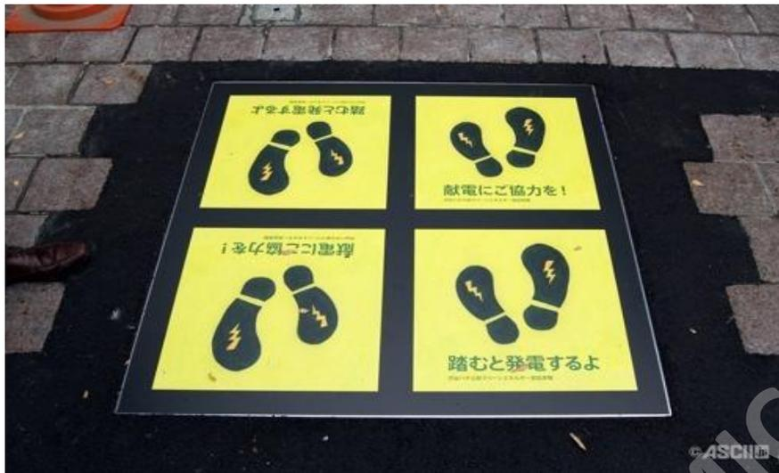
Imagen 3: Baldosa piezoeléctrica utilizada en Japón
