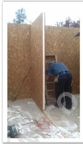
*Figura 16, Paneles Sip Ampliación.*
