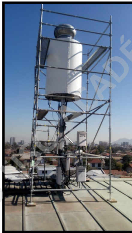
Radomo con fibra de vidrio Fuente: Google
