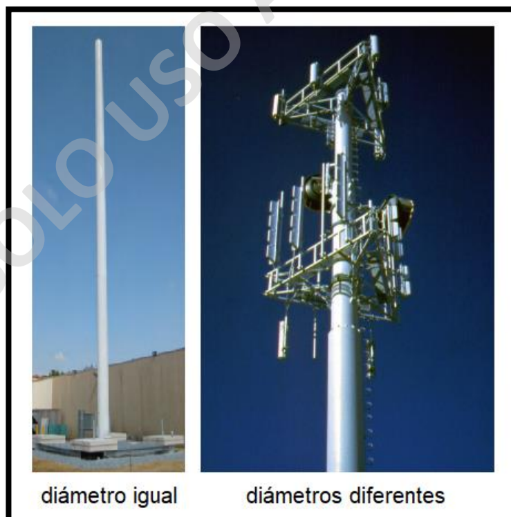
Imágenes de tipos de tipo de estructura de monopostes Fuente: Google
