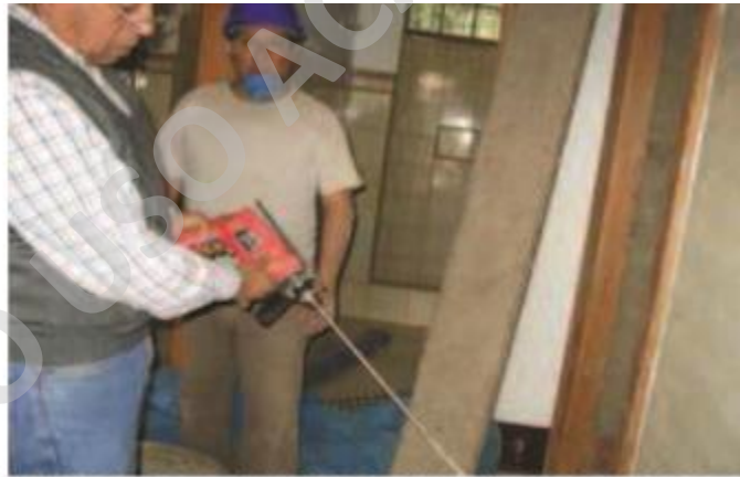
TALADRO TIPO TEY Y BROCA CON ADATADOR Y EXTENSION PARA PERFORACIONES
