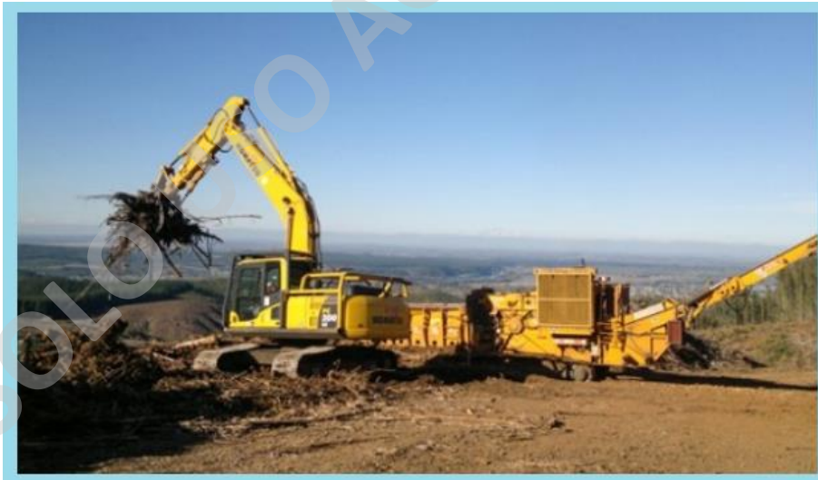
Figura 2. 4 Energía de la Biomasa
