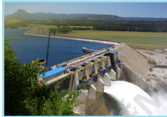
Figura 2. 3 Central hidroeléctrica Pelelfu
