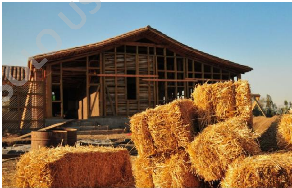
Foto 4.- casa de fardos, no portante
