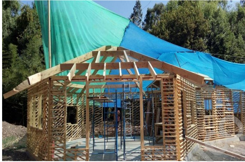
Foto 1.-Muros armado con técnica de quincha. Fuente propia
