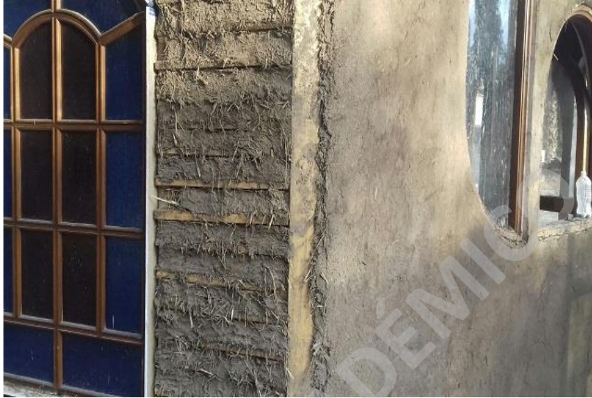
Foto 3.- Imprimación, revoque grueso. Fuente propia
