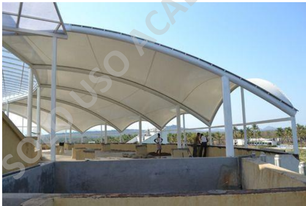
Figura 29 Toldo manufacturado en textil fotocatalítico (Europa)
