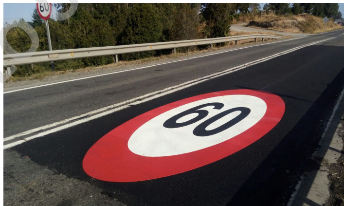
Figura 57. Material Preformado Velocidad Máxima 60 km/hr Fuente: Obra Puerto Montt, Región de Los Lagos. Año 2018.
