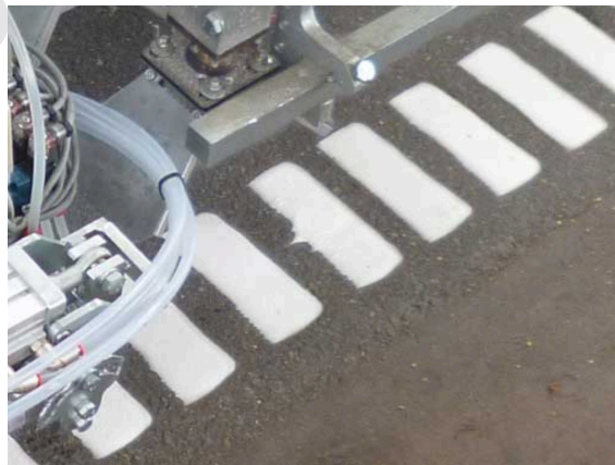
Figura 77. Demarcación Termoplástica Multipunto con forma de Perfil Transversal
