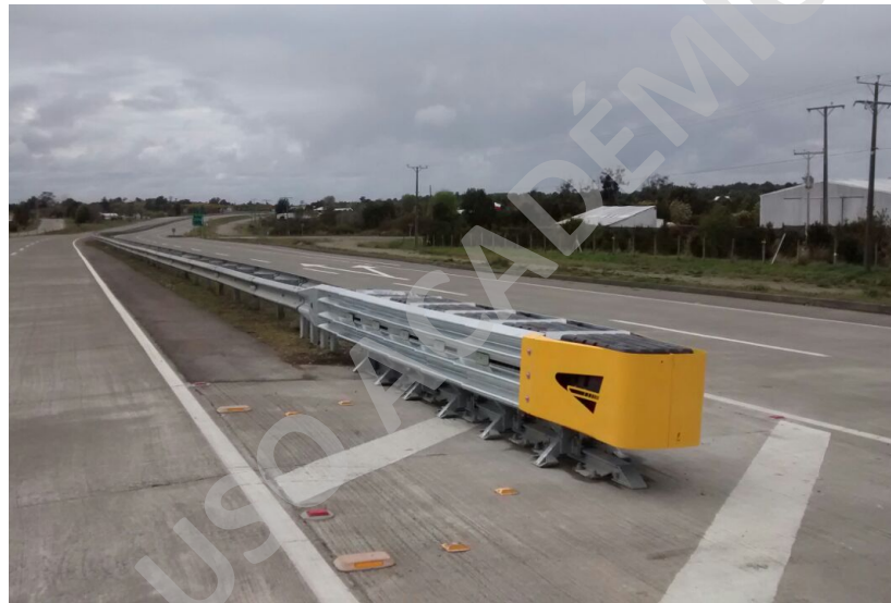
Figura 74. Amortiguador de Impacto con capacidad de redireccionamiento Fuente: Obra Llanquihue, Región de Los Lagos. Año 2015.
