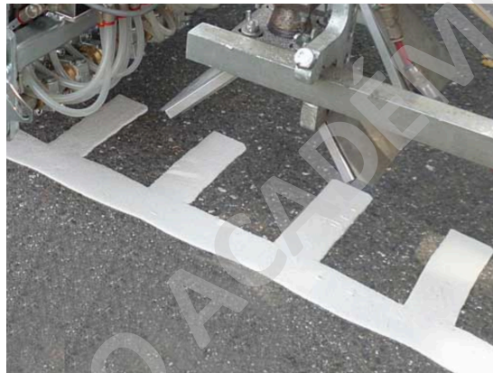
Figura 76. Demarcación Termoplástica Multipunto con forma de Líneas Perfiladas
