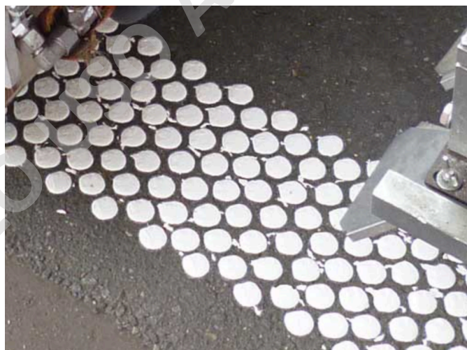
Figura 79. Demarcación Termoplástica Multipunto en forma Redonda Fuente: Hoffman – Road Marking Systems
