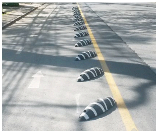
Figura 64. Elemento canalizador para ciclovía Fuente: Catálogo Seguridad Vial Empresa Lorenzini. Año 2015.
