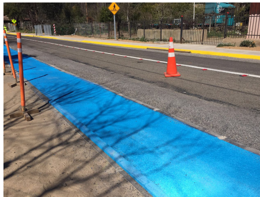
Figura 56. Pintura Plástico en Frío en ciclovía Fuente: Obra Las Dichas, año 2016, Región de Valparaíso
