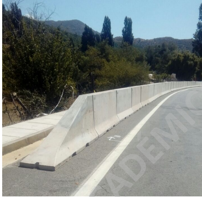
Figura 67. Ilustración Barrera de hormigón tipo F Fuente: Obra Cobertizos Los Andes, Región de Valparaíso. Año 2018.
