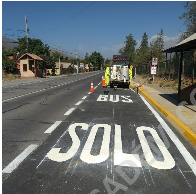
Figura 58. Material Preformado Solo Bus Fuente: Obra Cobertizos Los Andes, Región de Valparaíso. Año 2018.
