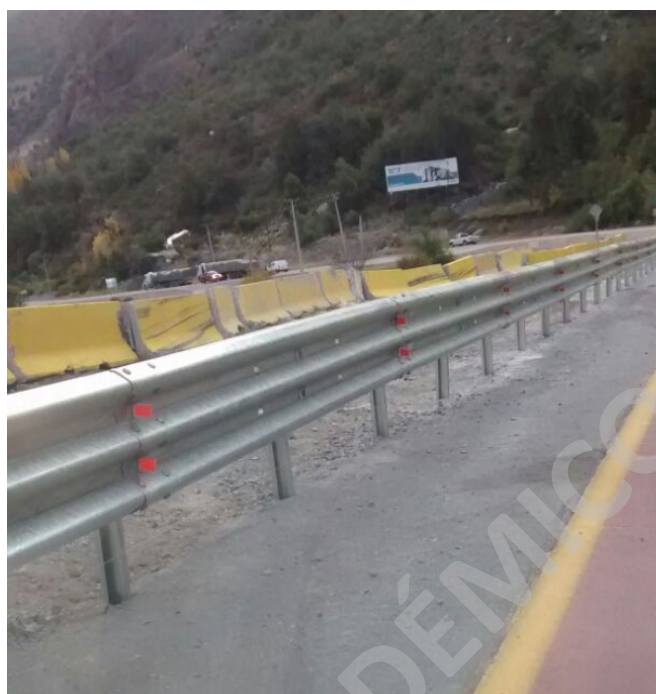
Figura 68. Barrera Metálica hincada Fuente: Obra Global Los Andes, Región de Valparaíso. Año 2016.
