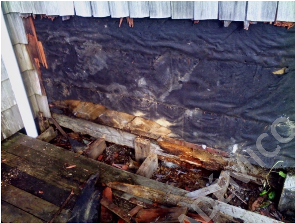
Foto 11 Sauna en remodelación Fuente propia
