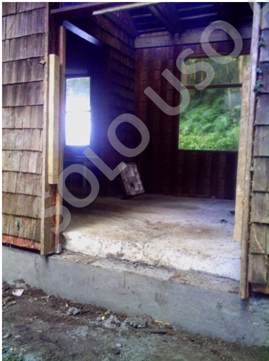
Foto 12 Sauna en remodelación Fuente propia
