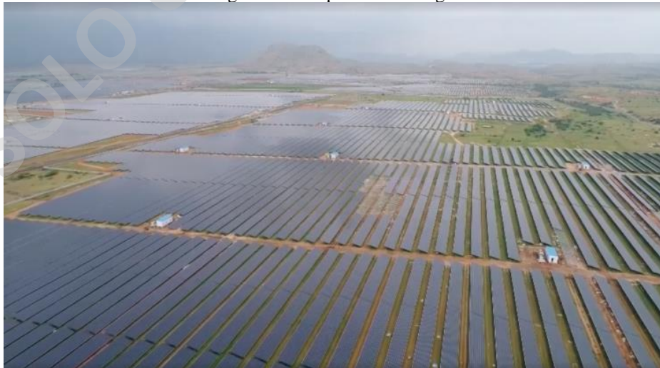
Imagen N°4 Parque Solar Pavagada
