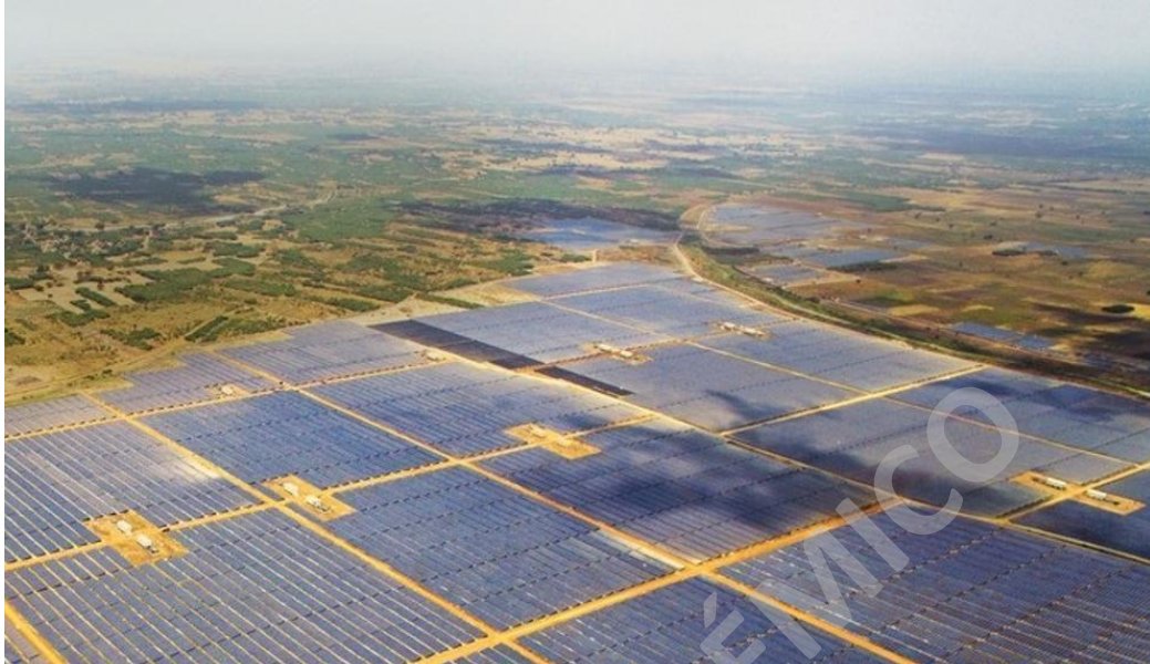
Imagen N°3 Planta Solar de Kamuthi
