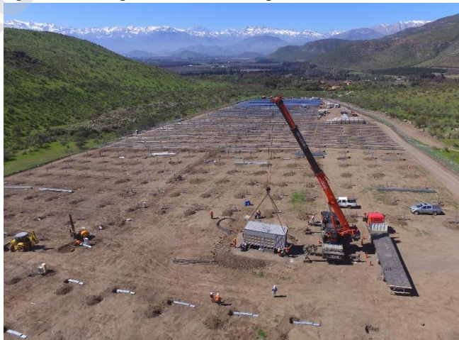
Imagen N°9 “Maquinarias utilizadas para movimientos de tierra y
