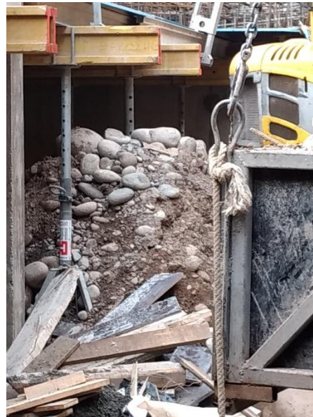
Imagen 45.- Excavaciones para subterráneos en proyecto en comuna Las Condes
