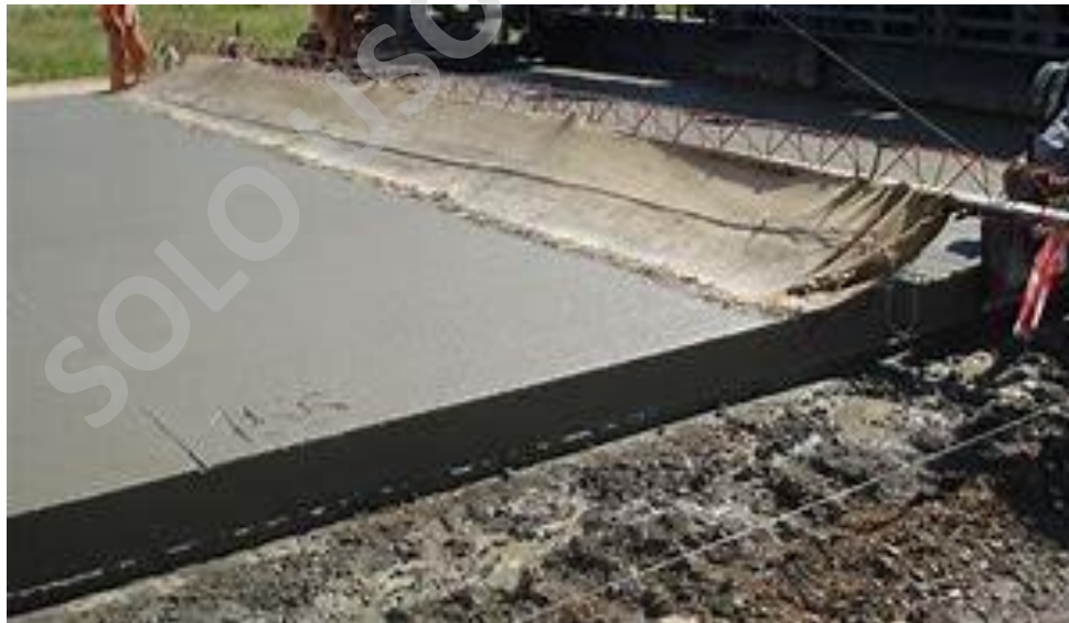
Imagen 10.- Pavimento de hormigón
