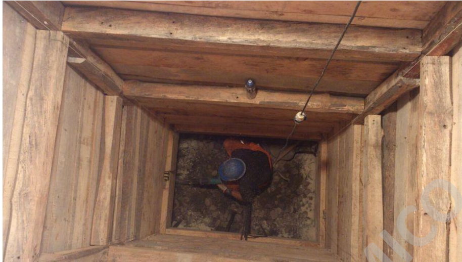
Imagen 14.- Excavación manual de pila de socalzado
