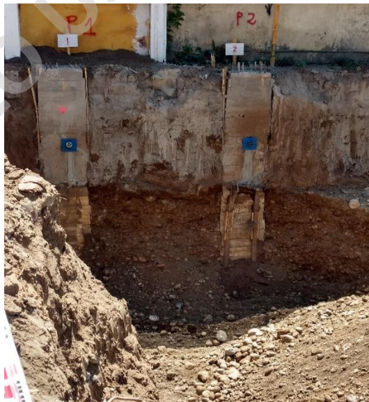
Imagen 47.- Excavaciones de subterráneos para proyecto en la comuna de Ñuñoa
