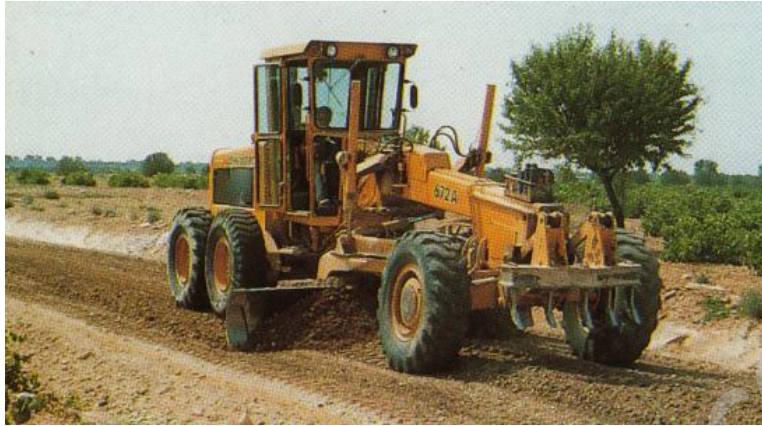
Imagen 8.- Colocación de las capas granulares de pavimento flexible
