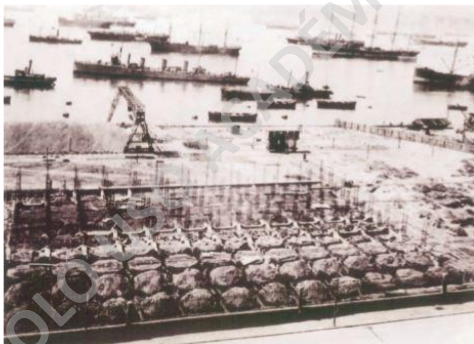
3.- Cajones celulares, construcción rompeolas Valparaíso.
