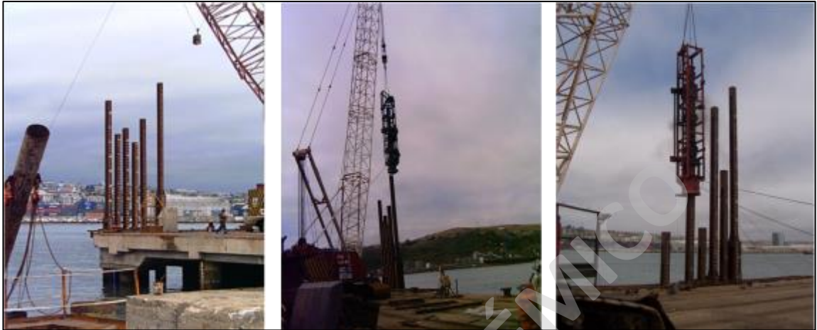
47.- Ampliación del sitio 1 del Puerto de San Antonio, tablestacas hincadas en el muelle antiguo.
