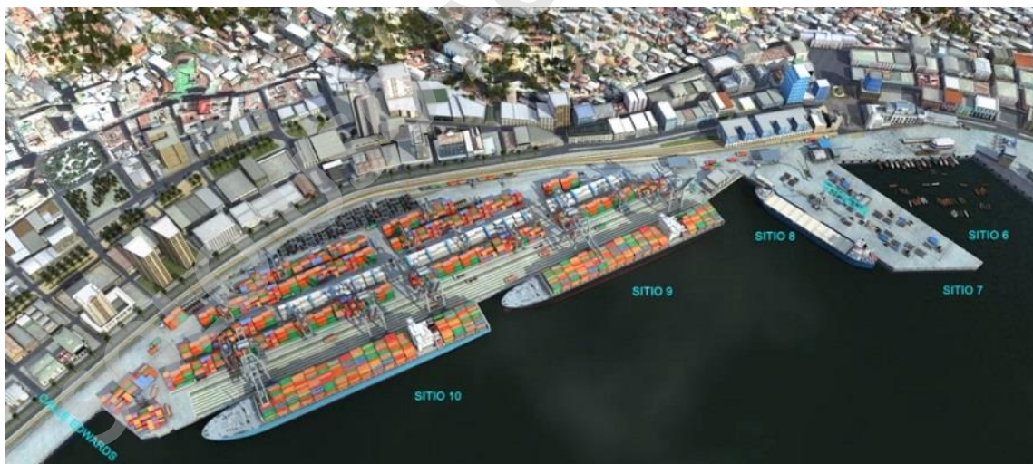
86.- Proyección terminal de contenedores de la ampliación del puerto de Valparaíso, junto al espigón y sus sitios de atraque (TCVAL).
