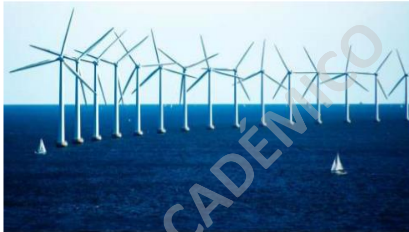
75.- Parque eólico marino instalado en Dinamarca.
