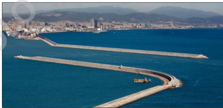
6 Dique de abrigo Sur y Este, Puerto de Barcelona 2009.
