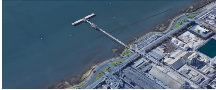
28.- Puerto de Huelva, España. Fuente: Google Earth.
