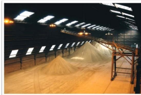
54.- Zona de pre-embarque para gráneles sólidos, puerto de Matarani, Perú.
