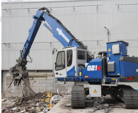
57.- Excavadora eléctrica de alto tonelaje.
