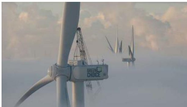
84.- Instalación de turbinas eólicas en el Puerto de Rotterdam.
