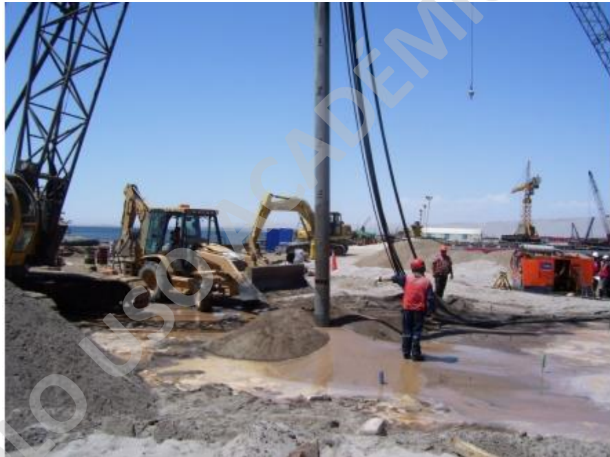
104.- Ejecución vibro compactación, obra Muelle antisísmico de Penetración, Terminal Puerto de Arica.
