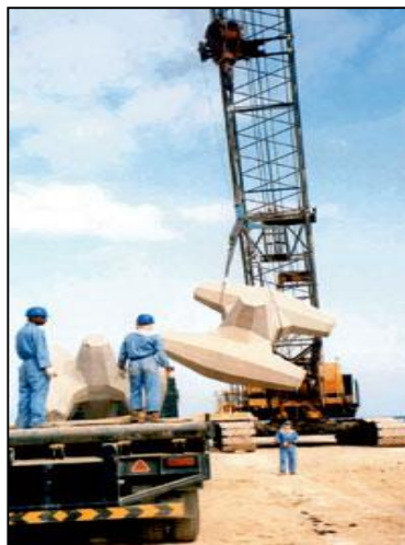
17.- Izaje del elemento prefabricado para Escollera. Fuente: Puertos: antecedentes para el proyecto, planificación, construcción y explotación. José Francisco Benavides y Otros
