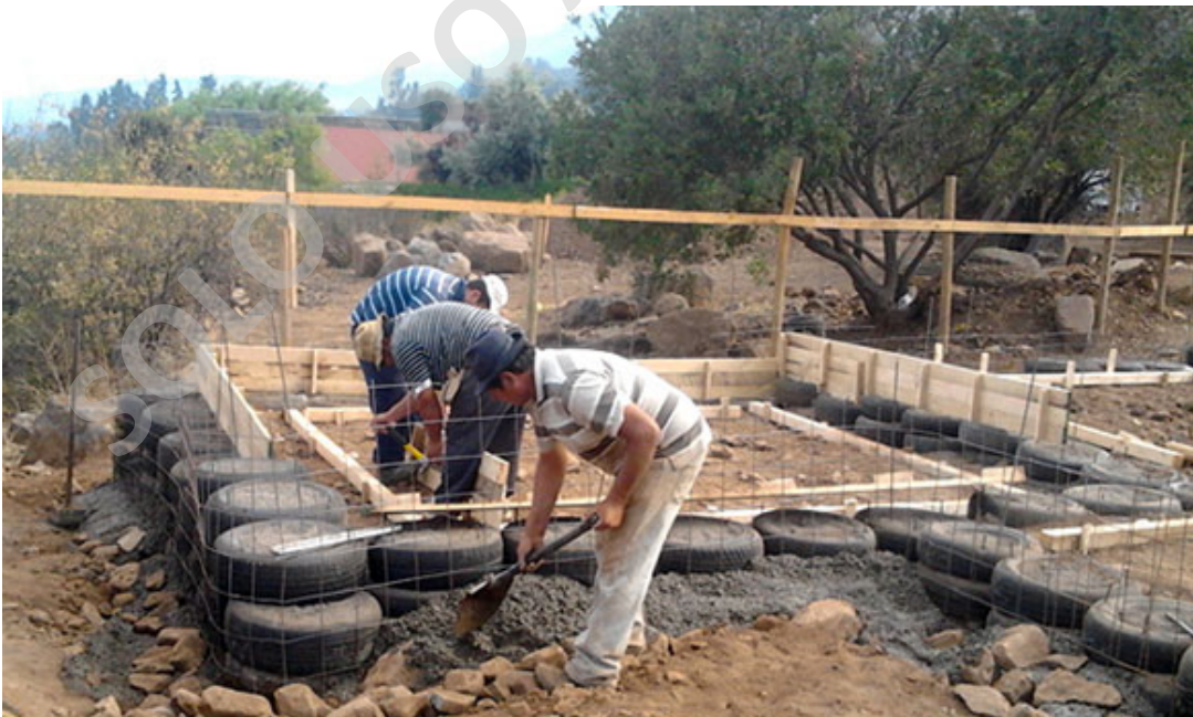
Ilustración 29, Cimientos de neumáticos
