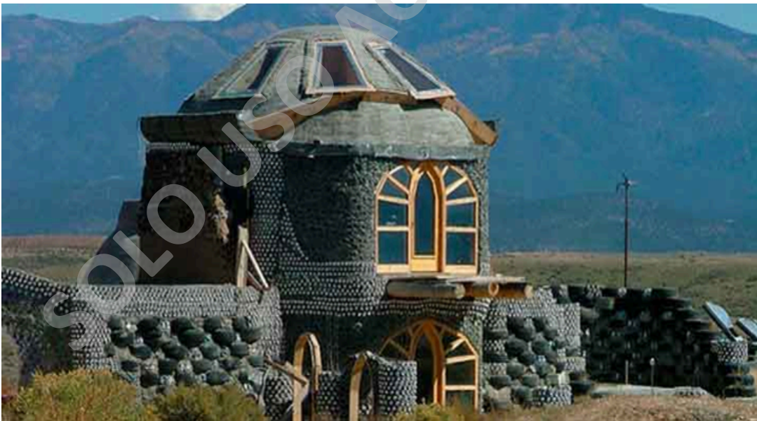
Ilustración 30, Casa construida de neumáticos y botellas
