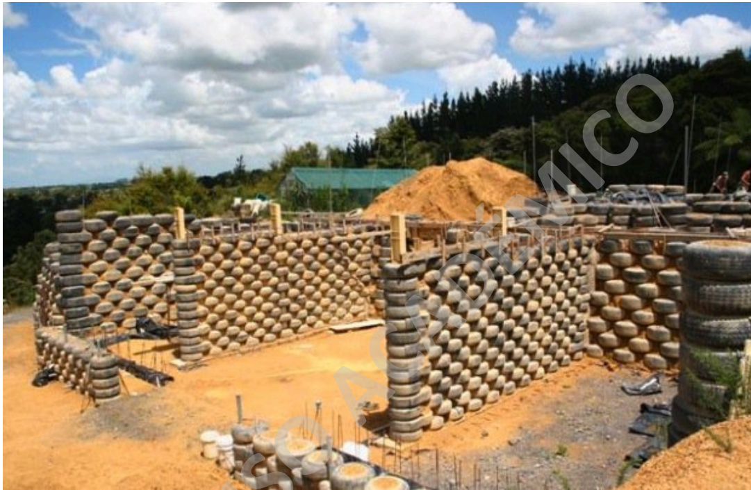
Ilustración 28, Construcción de muros con neumáticos
