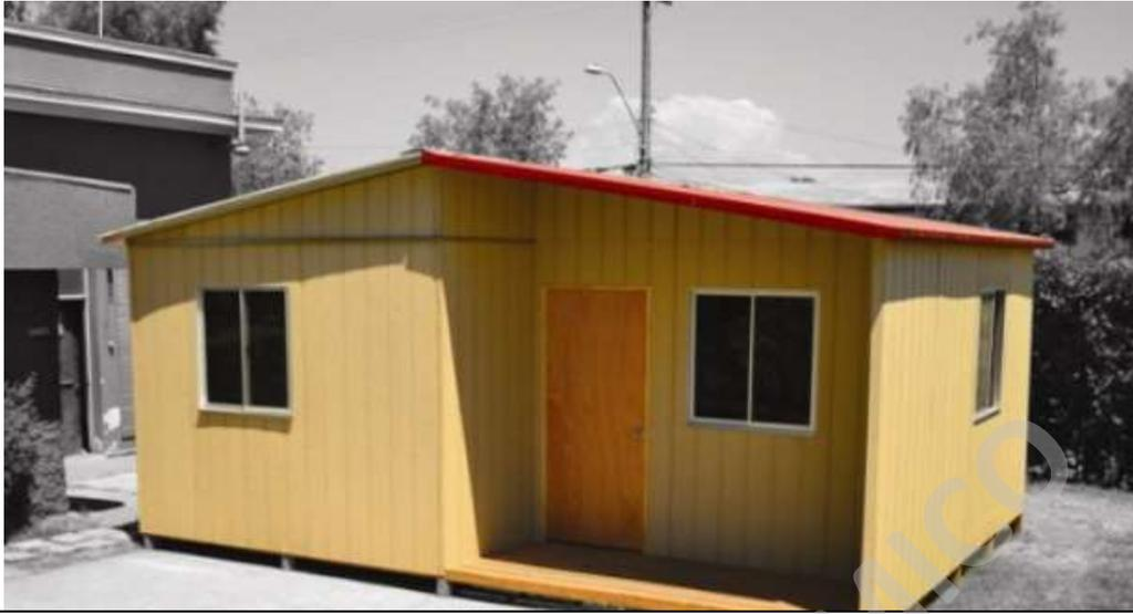
Foto 15. Revestimiento exterior con placa Smart Panel (Lignum, 2015).
