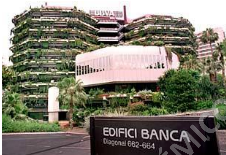
Figura 1.9 Edificio Banca Catalana
