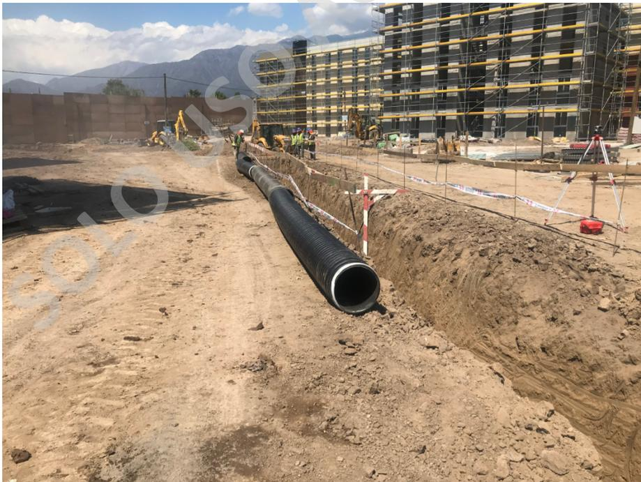
*Imagen Sello y cama de arena previo a Tendido de tubos Aguas Lluvias*
