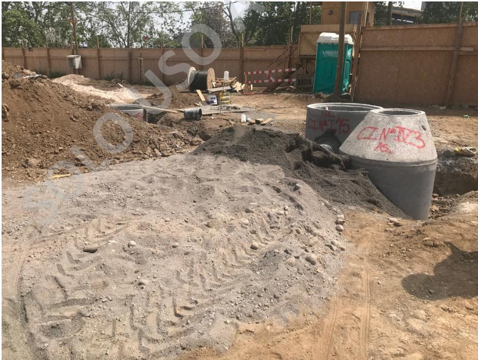
*Imagen Cámaras de Inspección Aguas Servidas*
