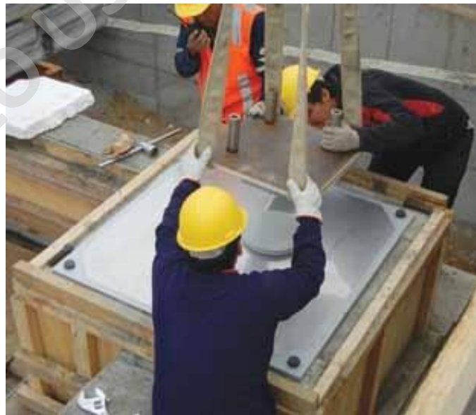
Figura 3. 4 Apoyo deslizamiento plano
