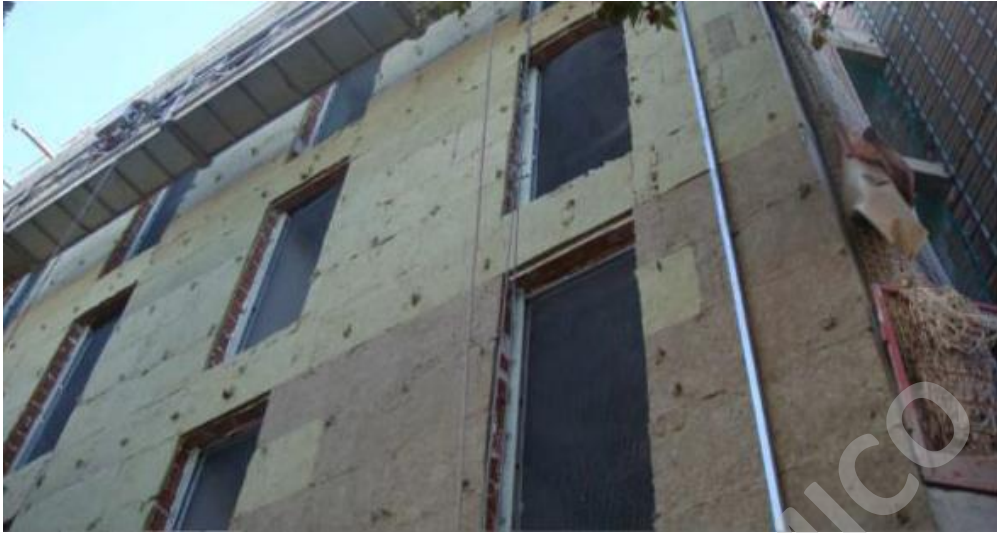
Figura 40 Ejecución de la fachada
