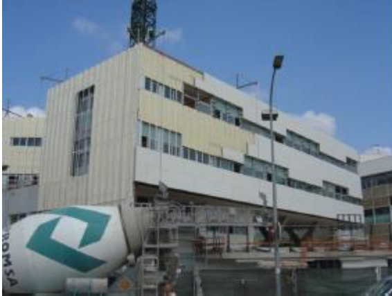
Figura 37 Construcción de la fachada
