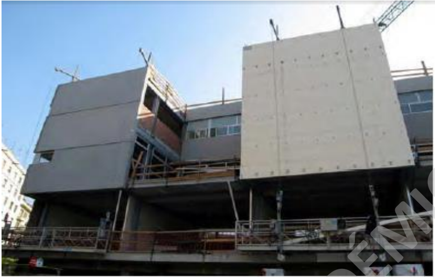
Figura 35 Construcción de las fachadas ventiladas (PARDAL, 2010)
