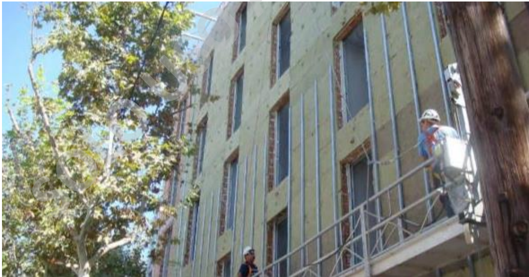
Figura 39 Ejecución de la fachada
