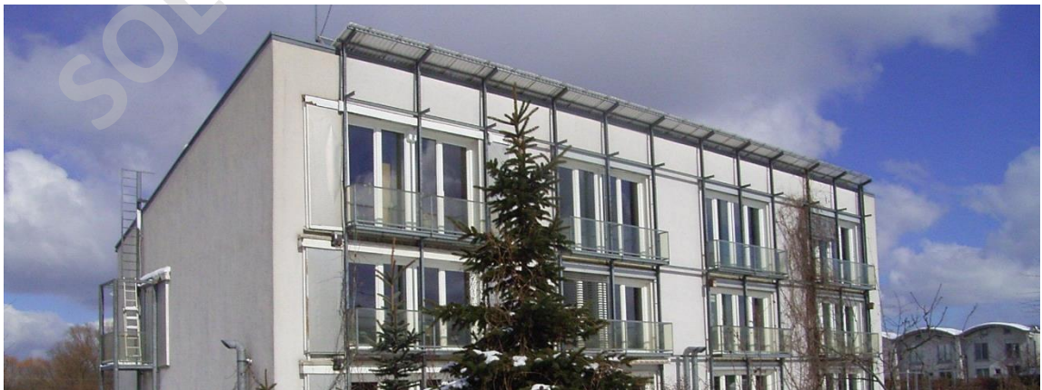
Imagen 4, La primera Passivhaus propiamente tal. Darmstadt, Alemania. Passivhaus Institut
