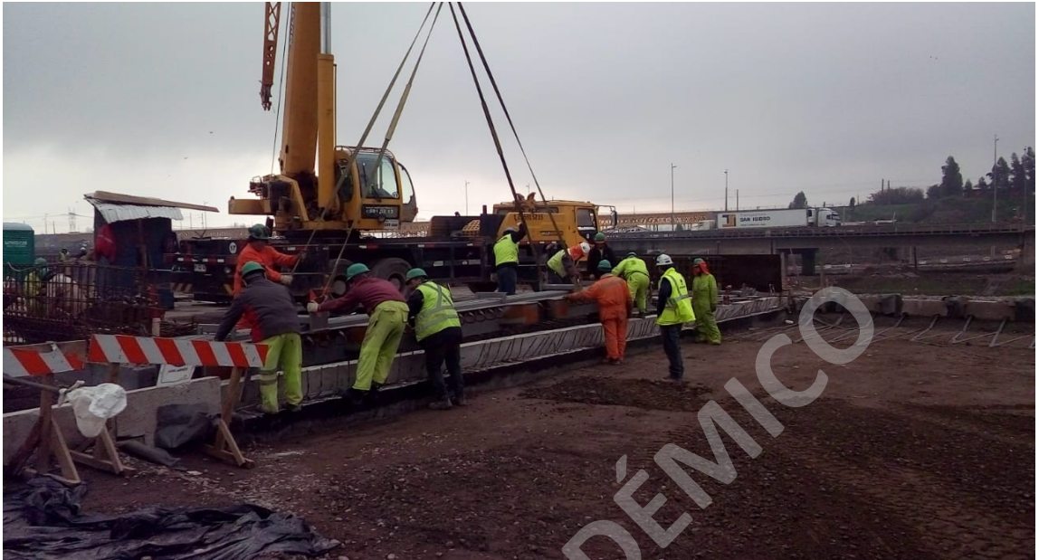
Figura 17: Instalación Junta de dilatación Nuevo Puente Maipo.
