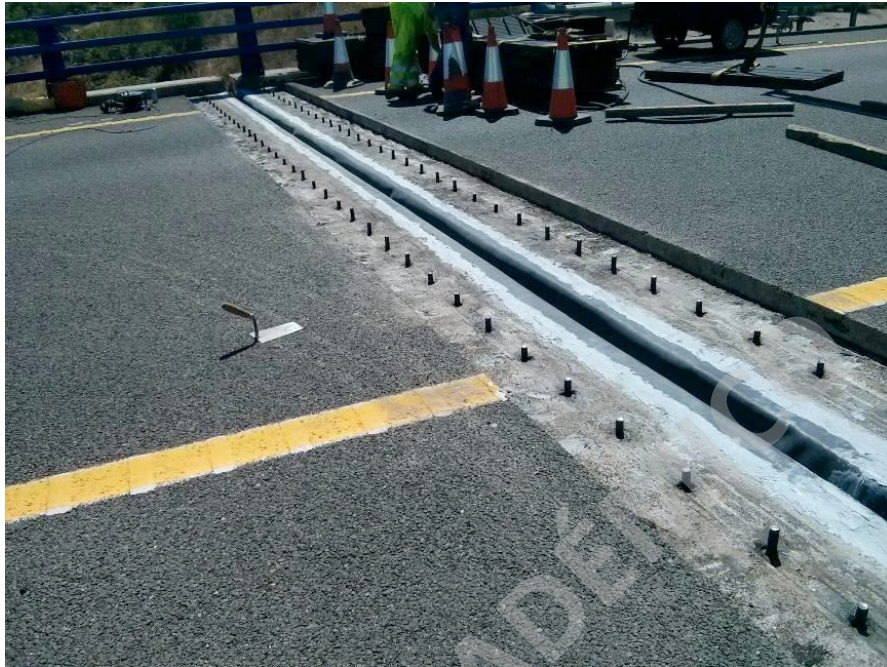
Figura 22: Colocación de anclajes
