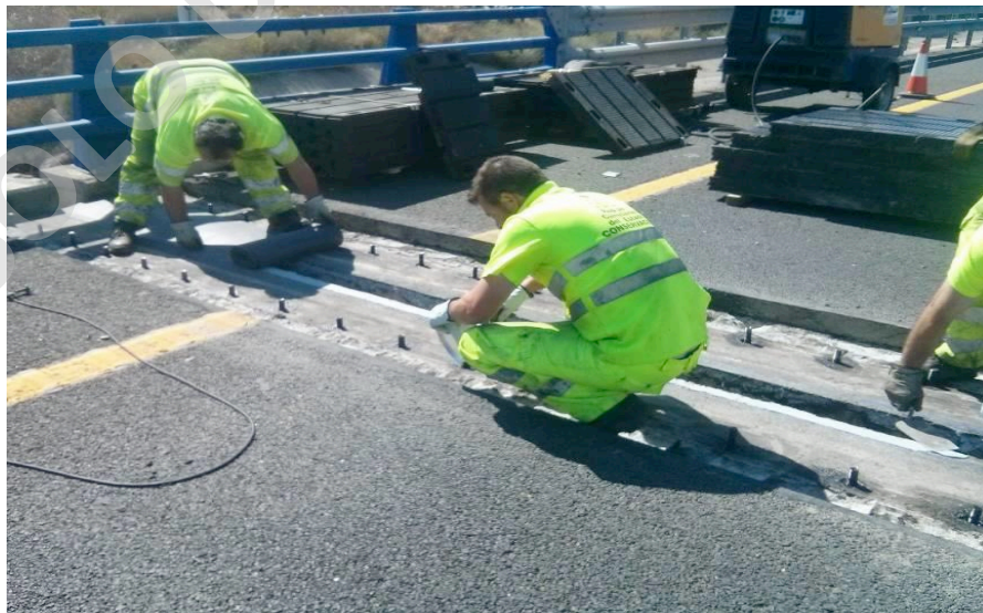
Figura 21: Colocación de la banda
