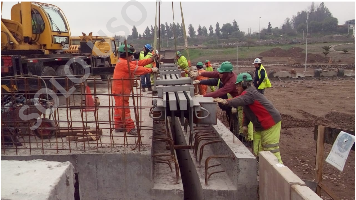
Figura 16: Instalación Junta de dilatación Nuevo Puente Maipo.
