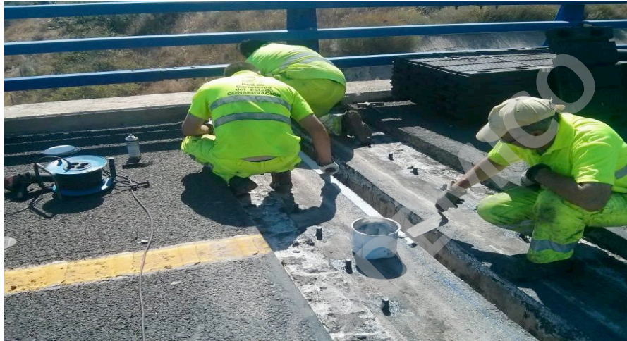
Figura 20: Aplicación de mortero epoxico en (tablero o estribo)
