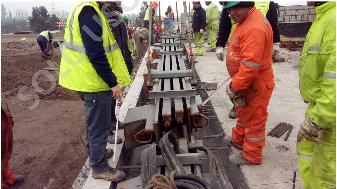
Figura 18: Instalación Junta de dilatación Nuevo Puente Maipo.
