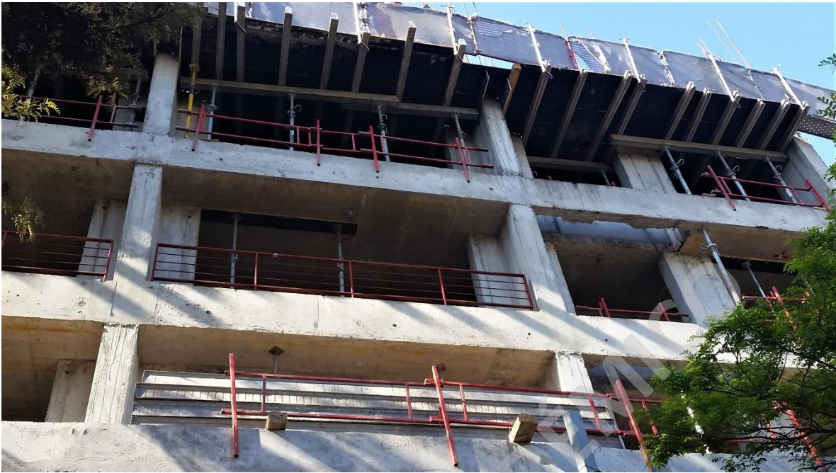
Foto 1.21: Fachada obra General Amengual Fuente: Elaboración propia
