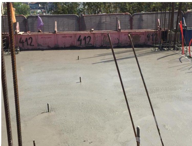
Foto 1.14: Moldaje especial instalado Obra Amengual Fuente: Elaboración propia
