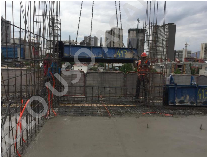
Foto 1.13: Instalación Moldaje especial Obra Amengual Fuente: Elaboración Propia
