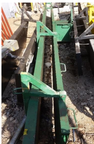
Foto 1.10: Moldaje especial en terreno Fuente: Elaboración propia
