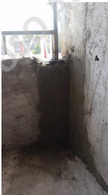
Foto 1.27: Reparación junta viga/muro Fuente: Elaboración propia
