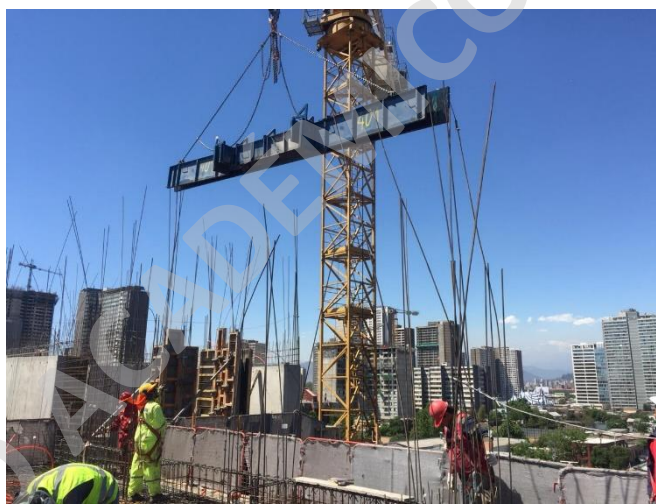
Foto 1.11: Grúa trasladando moldaje especial Fuente: Elaboración propia
