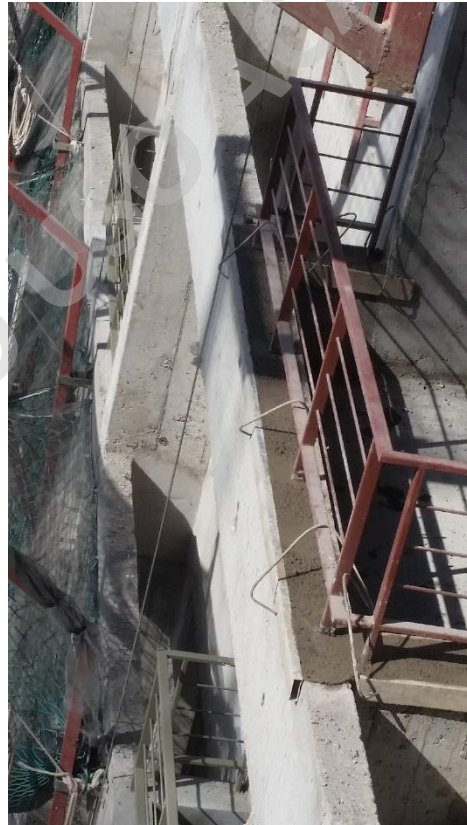
Foto 1.31: Barda reparada Fuente: Elaboración propia
