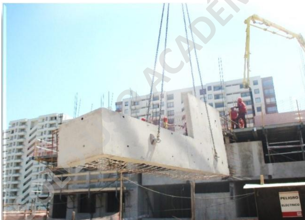
Foto 1.22: Izaje viga Prefabricada
