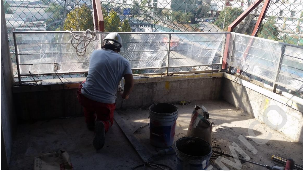
Foto 1.30: Albañil reparando barda Foto: Elaboración propia
