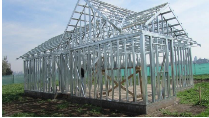
Figura 10: Vivienda Realizada En Metalcom.
