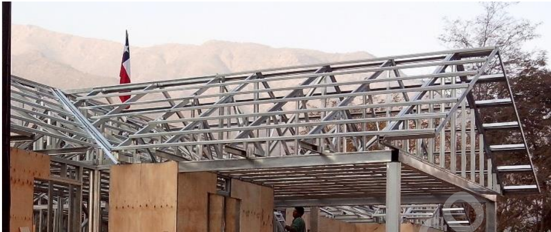
Figura 21; Cercha de Metalcom Montada.
