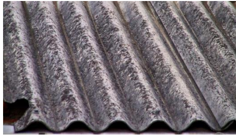
Figura 8: Plancha de Asbesto cemento.
