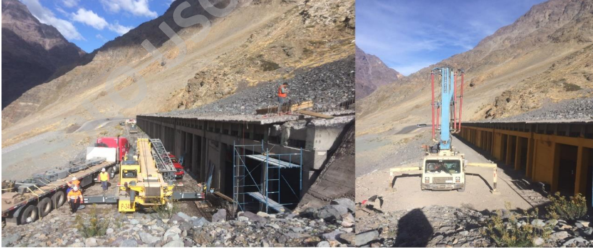
Figura 4. 6 Reparación de Cobertizos, caso estudio ruta 60 CH
