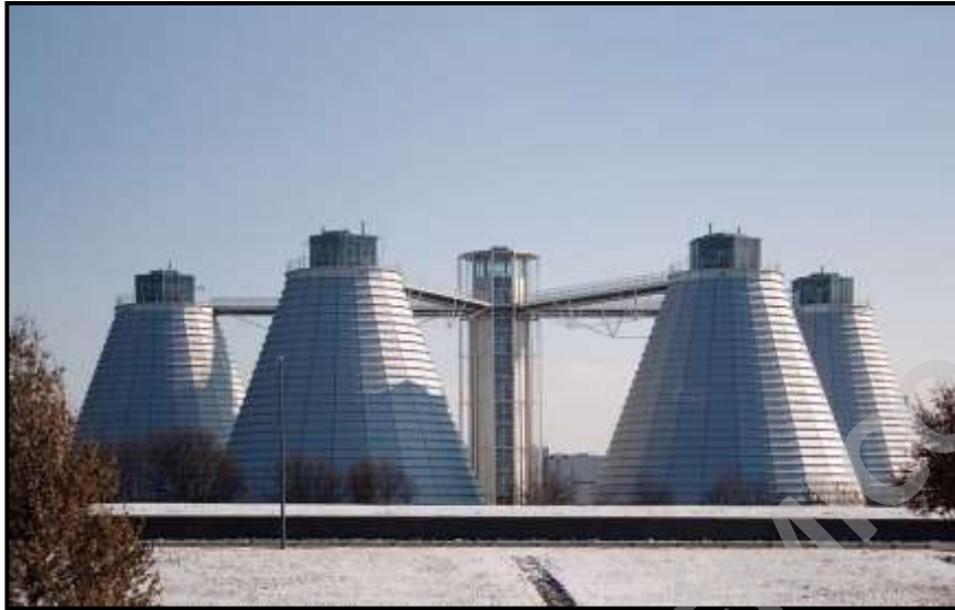
Imagen N° 15: Planta de tratamiento de aguas residuales de Múnich (Alemania)
