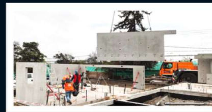
Montaje de paneles Baumax, Baumax
