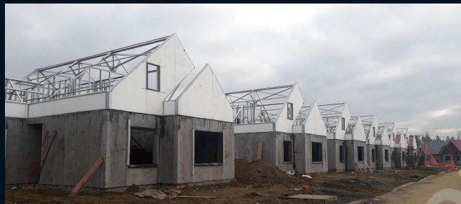
Proyecto Valle Noble de Concepción construido con el sistema de paneles Metalpol, 184 casas prefabricadas en dos meses, realizando 3 entregas semanales de 24 casas, RC Tecnova
