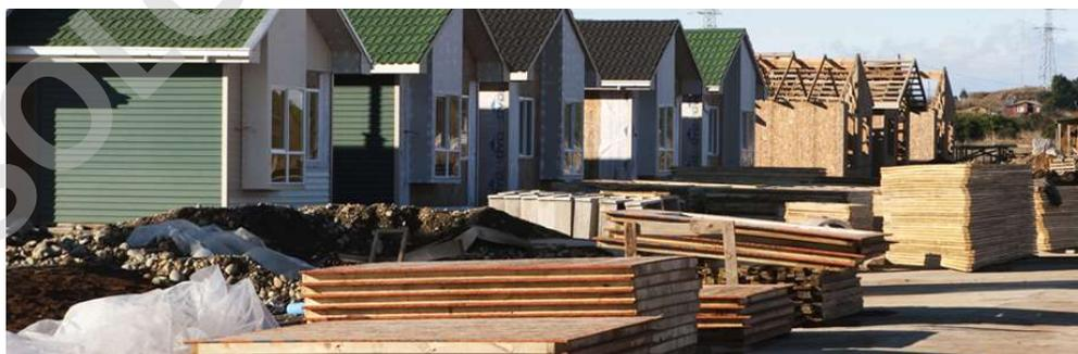
Figura 6: Casas Fabricadas por Easywood con el Sistema constructivo modular industrializado, EASYWOOD.
