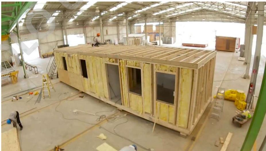
*Figura 7: Modulo tridimensional, producido en fábrica.*
