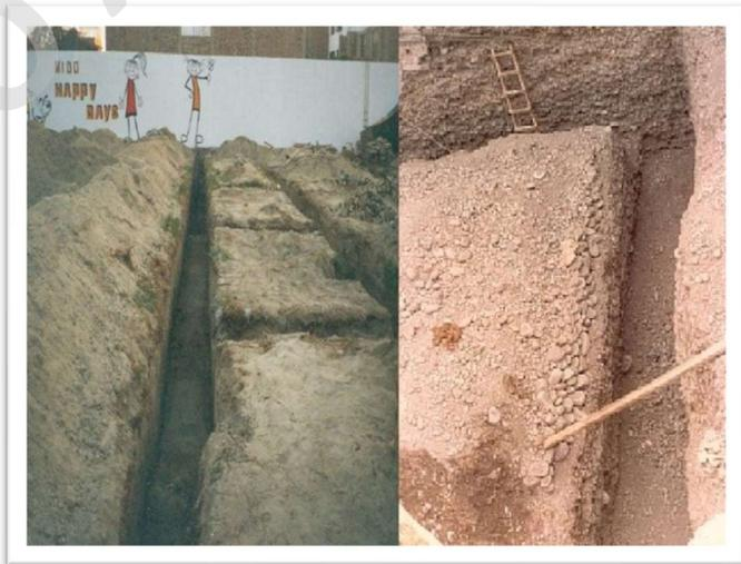
*Figura 101: Excavaciones de zanjas para cimientos de la vivienda.*
