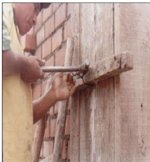
*Figura 110: Desencofrado de columnas*
