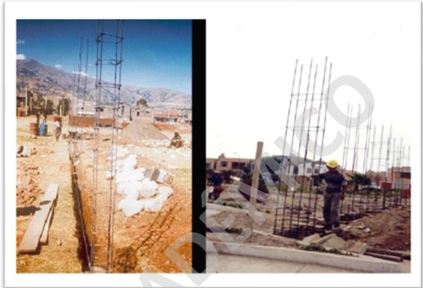
*Figura 102: Armado y habilitación del acero para columnas*
