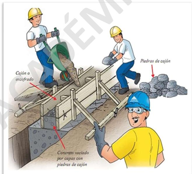
Figura 105: Vertido de concreto en sobrecimiento.
