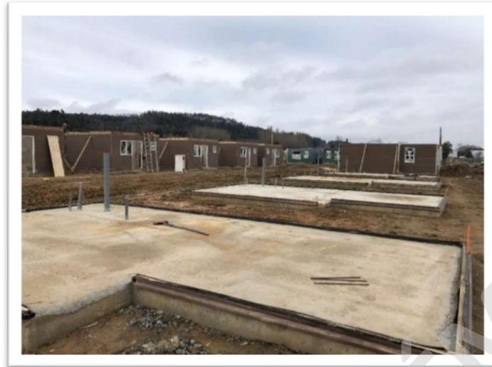
*Figura 85: Emplazamiento del radier de montaje para los módulos panelizados*
