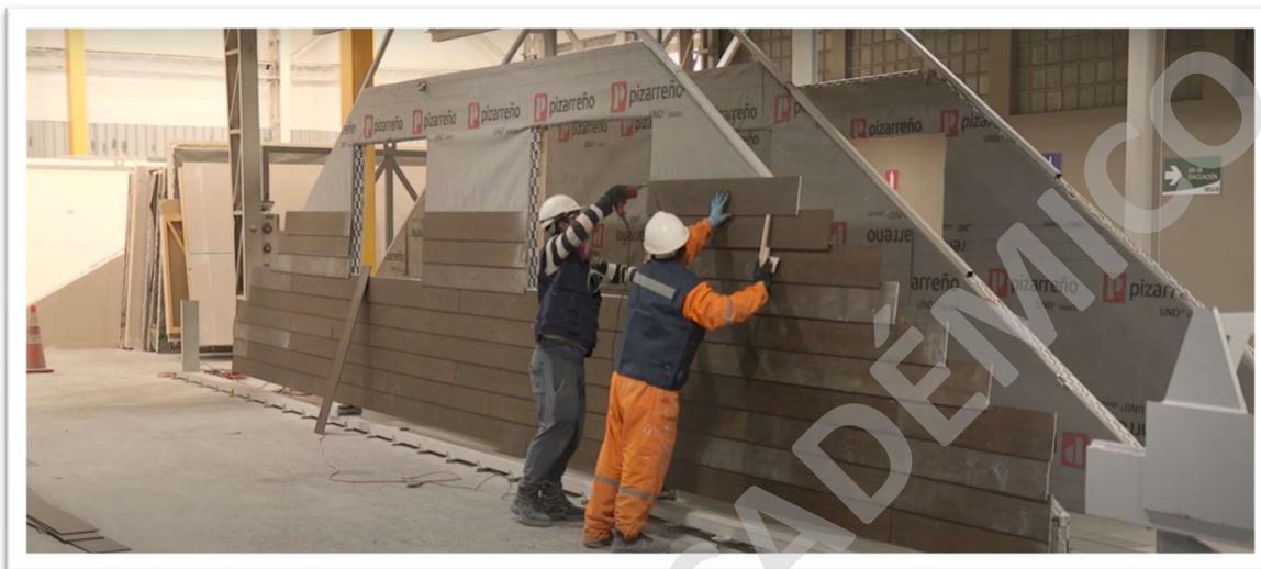
*Figura 94: Colocación de revestimiento exterior en fachadas de los muros panelizados.*
