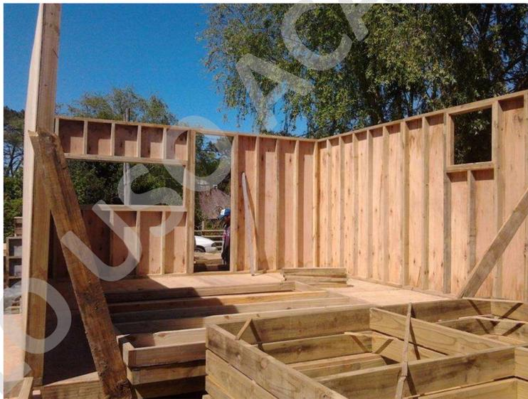
*Figura 8: Módulos panelizados, listos para ser empaquetados y transportados a la obra.*
