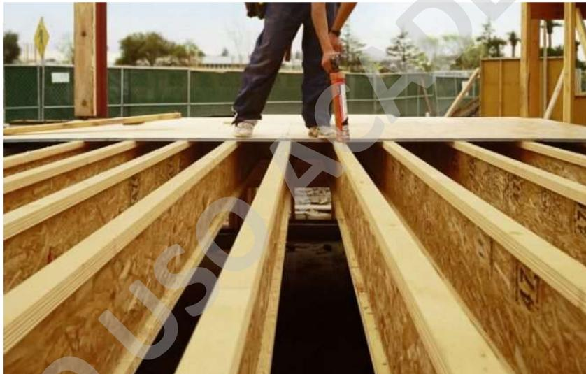
*Figura 14: Montaje de una estructura en madera correspondiente al entrepiso.*
