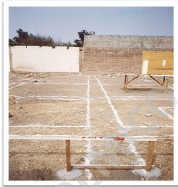
*Figura 100: Trazado y replanteo del terreno.*
