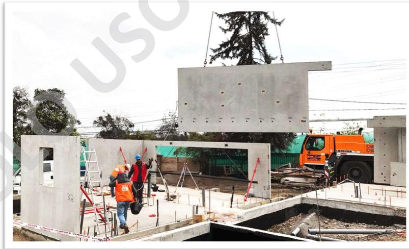
*Figura 4: Montaje de paneles Baumax, Baumax.*
