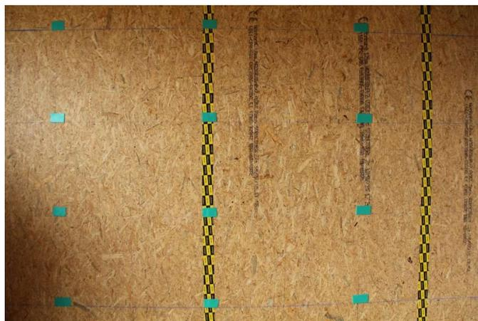
Figura 126: Ejemplo de correcto sellado de la capa hermética y replanteo de cinta para el sellado estanco de las penetraciones de clavos y tirafondos.
