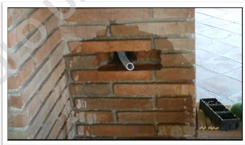
*Figura 114: Instalación de agua en un muro de albañilería*
