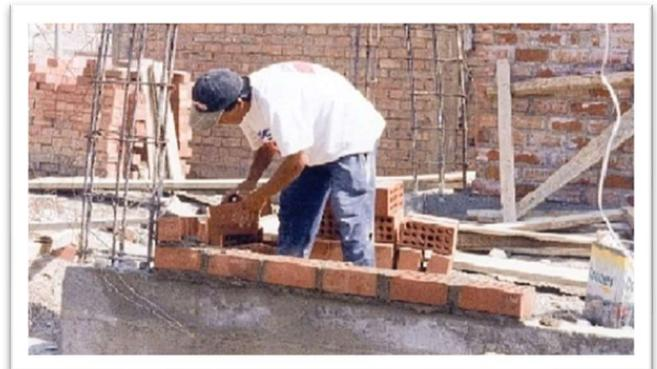
Figura 108: Asentamiento de ladrillos sobre los sobrecimientos para generar el muro.
