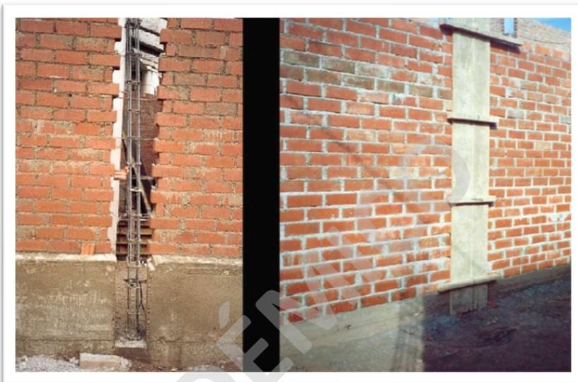
*Figura 109: Encofrado de columnas del muro de albañilería*
