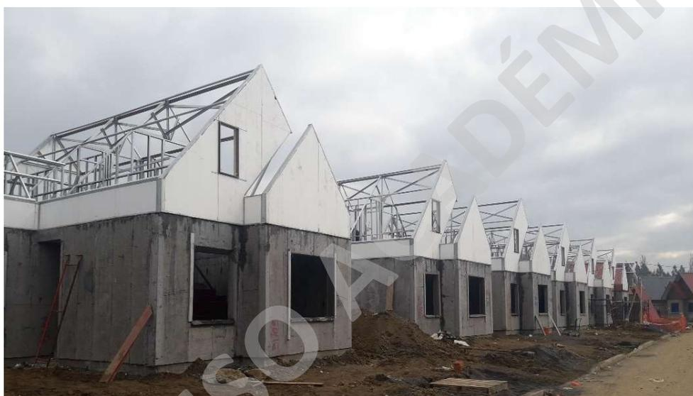
*Figura 5: Proyecto Valle Noble de Concepción construido con el sistema de paneles Metalpol, 184 casas prefabricadas en dos meses, realizando 3 entregas semanales de 24 casas, RC Tecnova.*
