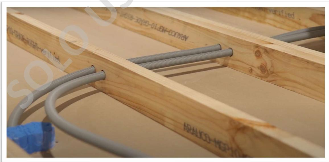
*Figura 91: Instalaciones eléctricas en muro panelizado.*
