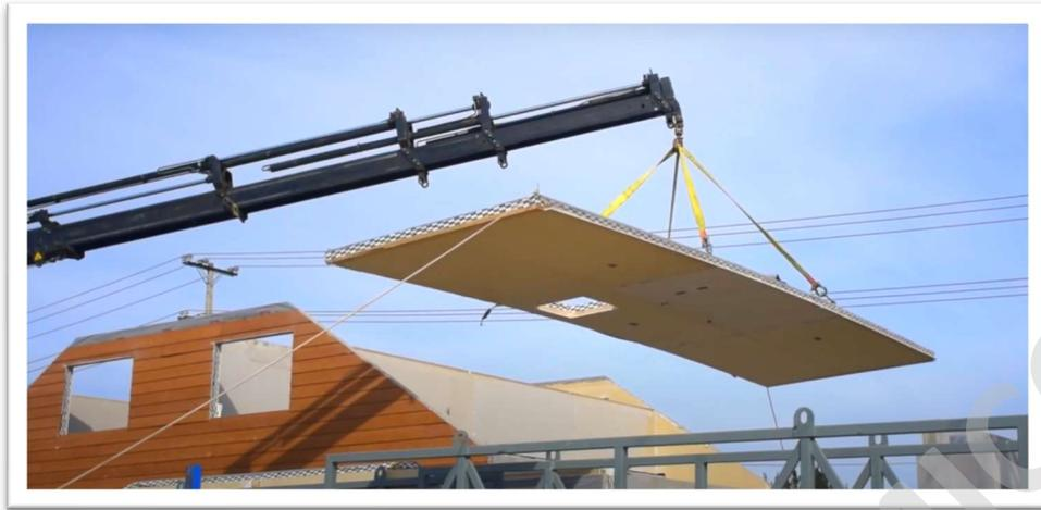
*Figura 97: Montaje en obra de cubierta de vivienda social, Módulos Panelizados*
