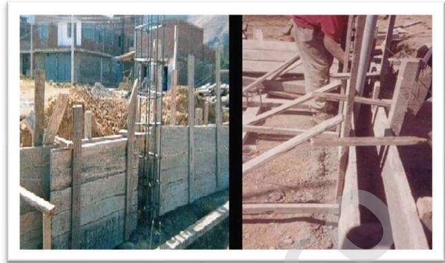
Figura 104: Encofrado de sobrecimientos
