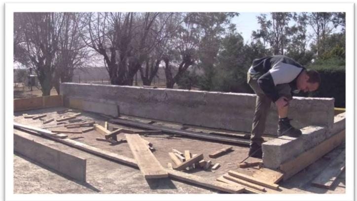
Figura 106: Desencofrado de sobrecimientos
