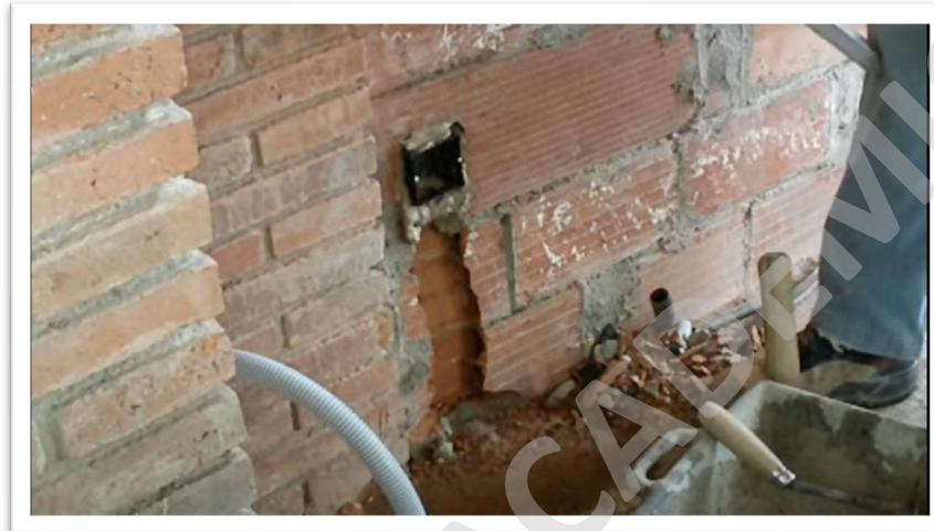
*Figura 113: Instalación de Caja eléctrica en un muro de albañilería.*
