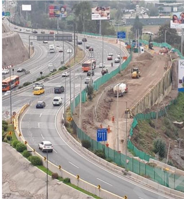
Ilustración 16 Trabajos en ejecución Ensanche Plataforma La Pirámide
