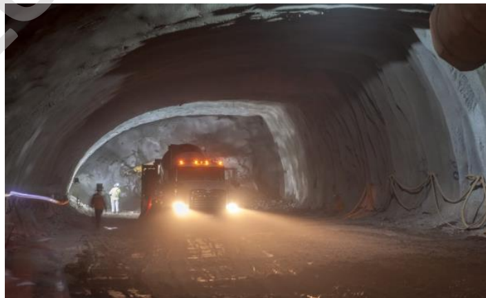
Ilustración 19 Excavación en la modalidad de túnel minero en la caverna de bifurcación.
