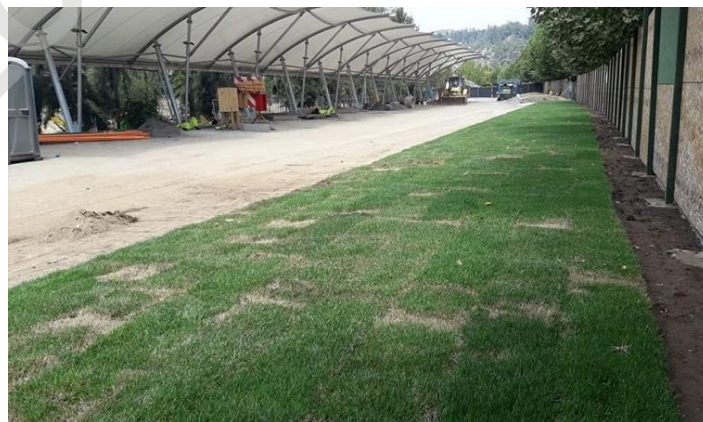
Ilustración 25 Habilitación de las instalaciones del Punto Limpio Provisorio
