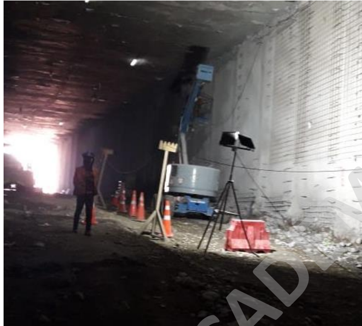
Ilustración 20 Excavación y ejecución de las estructuras que conformarán el ramal de acceso
