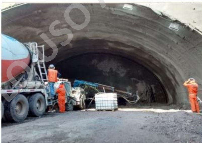
Ilustración 15 Excavación con maquinaria
