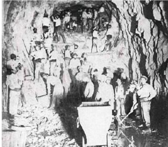
Ilustración 2 Trabajadores en las excavaciones
