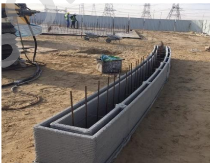
Imagen 24: Detalle muro con refuerzo
