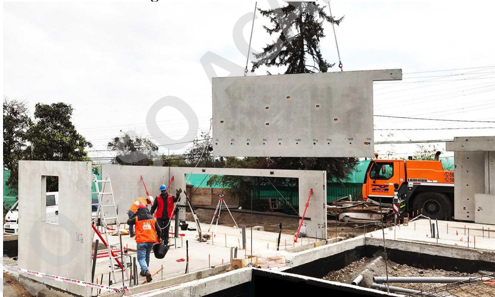
Imagen 33: Instalación Muro, Baumax.
