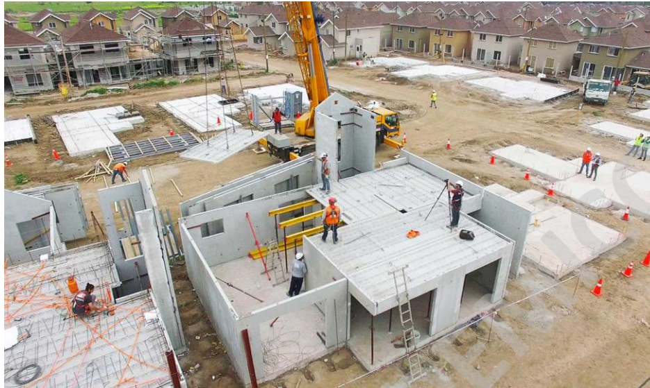
Imagen 33: Instalación Muro, Baumax.
