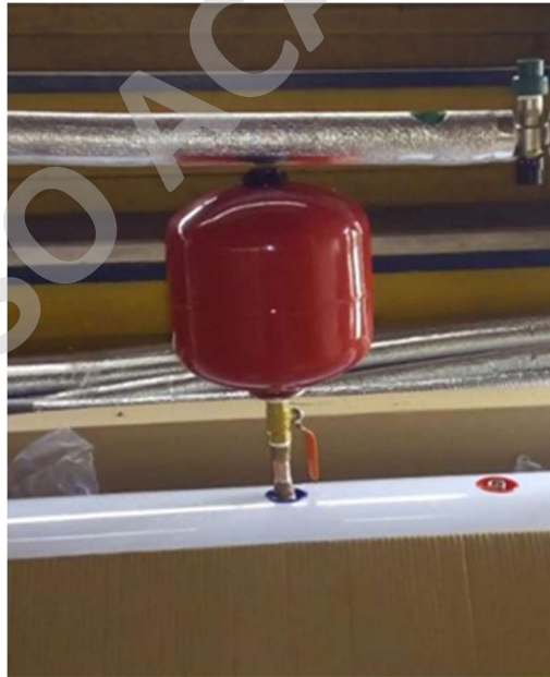
Imagen N°8: Estanque de Expansión.
