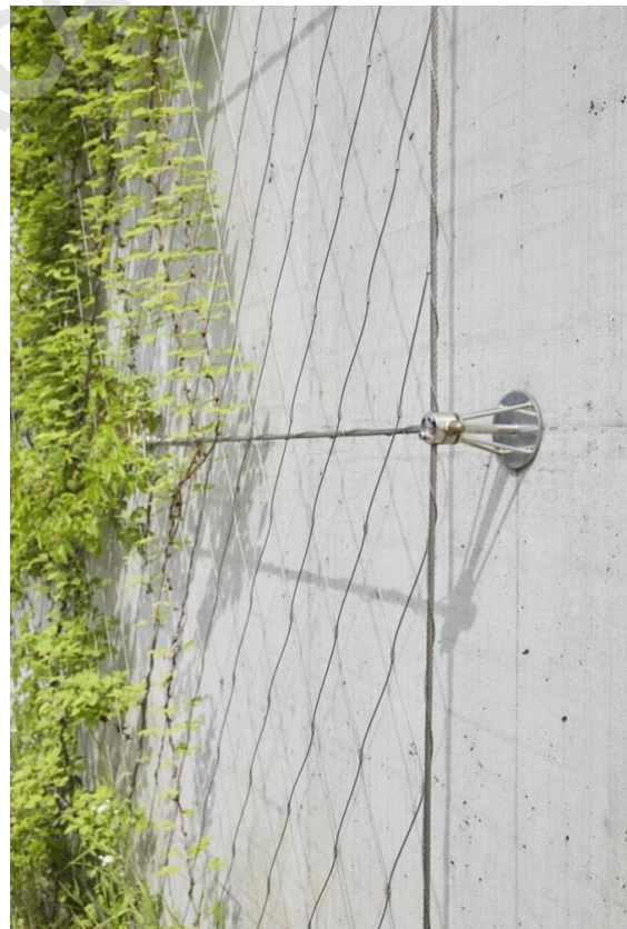
Imagen 18 Jardines verticales con cables de acero en forma de rombo Recuperado de https://plataformaarquitectura.cl
