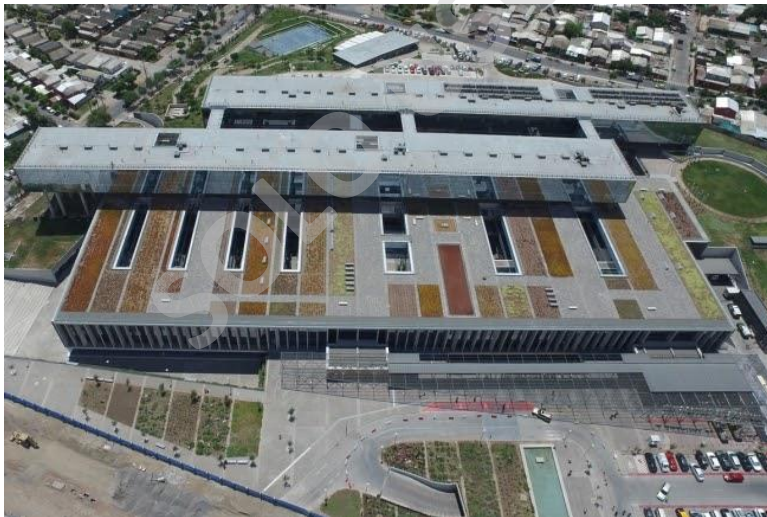
Imagen 8 Hospital del Carmen, BBATS Consulting & Projects SEP, Murtinho+Raby Arquitectos, 2013, Santiago, Chile Recuperado de https://construtorasanjose.com
