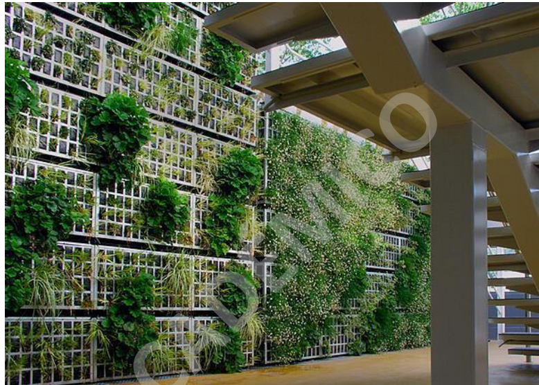
Imagen 19 Fachada vegetal con sistema de enrejado modular Recuperado de https://blog.laminasyaceros.com
