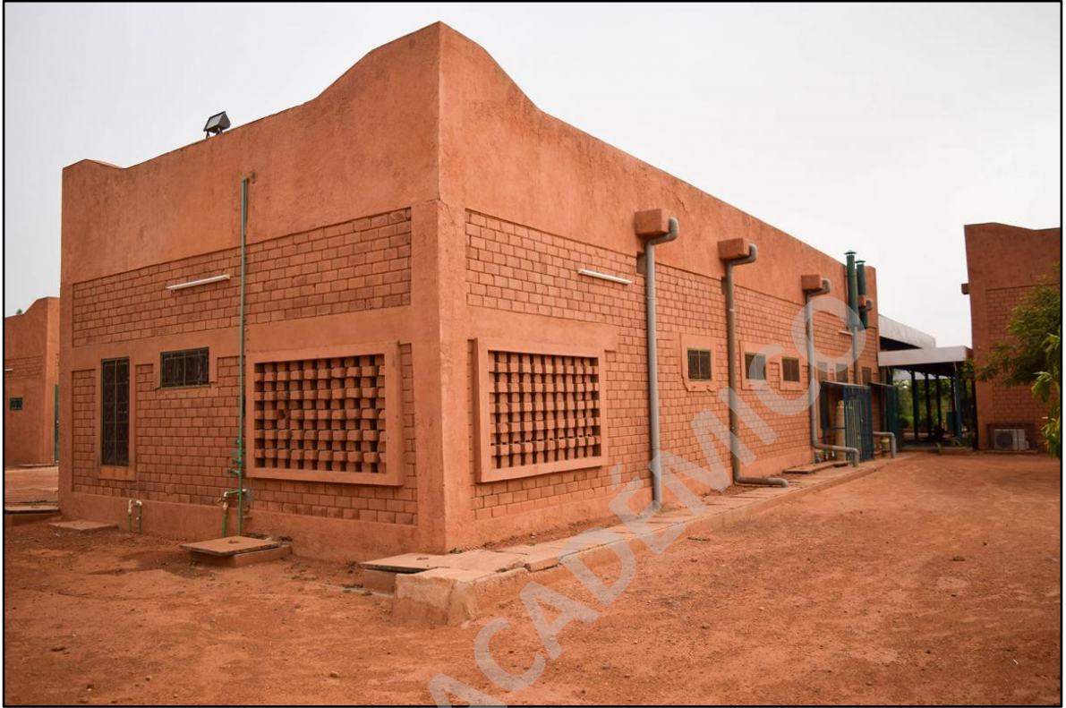
Imagen 05: Ejemplo de construcción en BTC.
