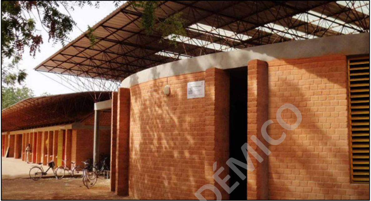
Imagen 02: Sistema de amarre y muros en BTC.
