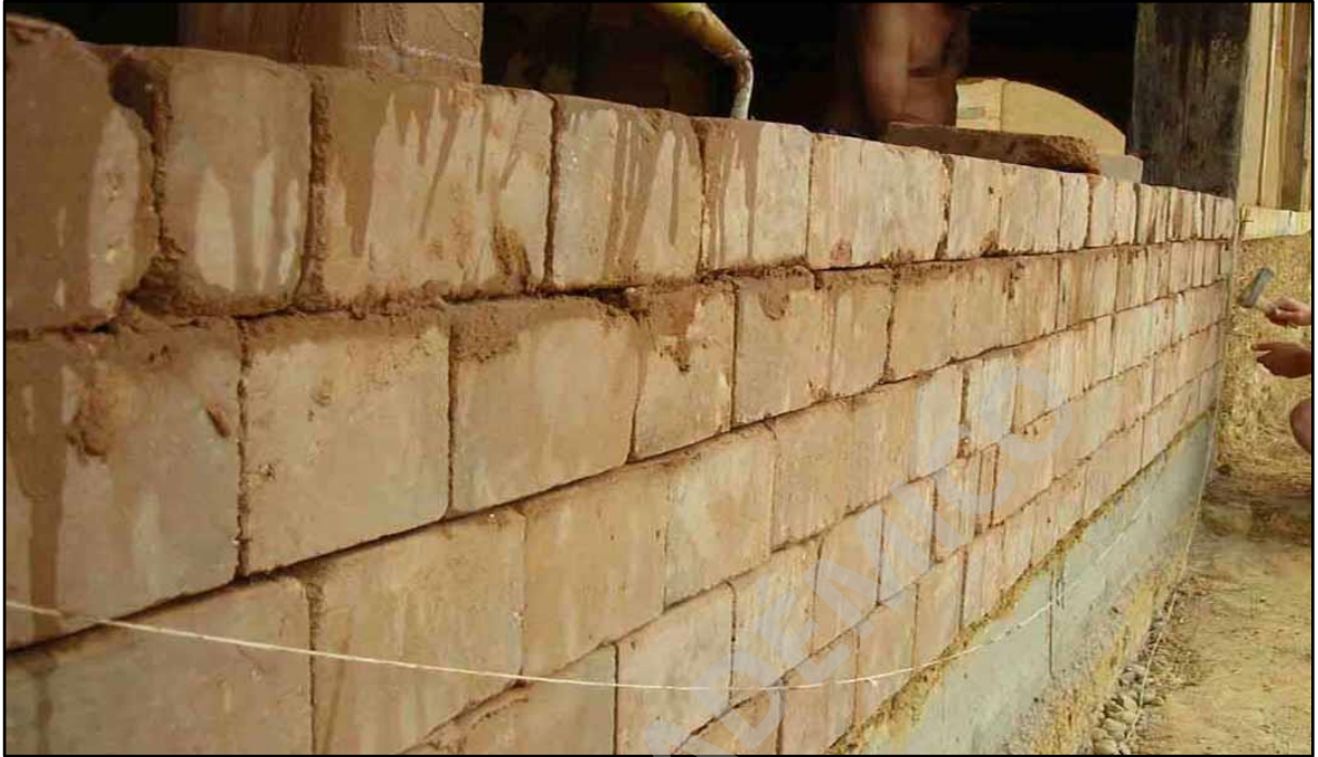
Imagen 04: Muro construido en BTC.
