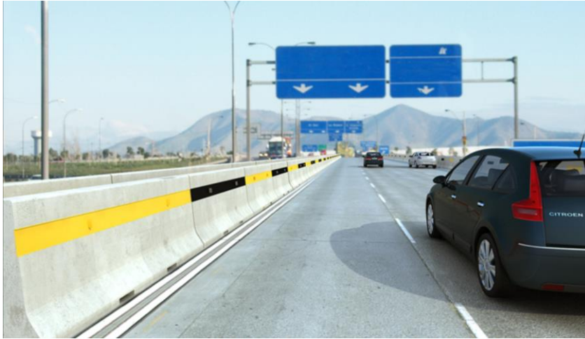
Ilustración 9: PLACA AMARILLA en defensa de hormigón
