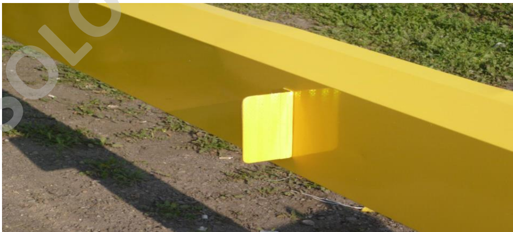
Ilustración 7: PLACA AMARILLA anti-nieve instalada
