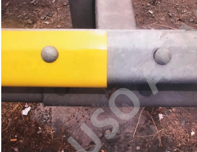
Ilustración 12: PLACA AMARILLA con los pernos instalados y apretados
